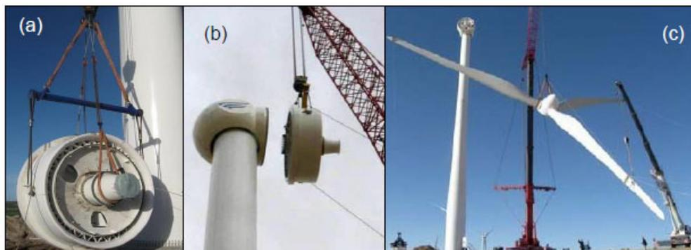
Figura 5. Foto combinada del izaje del generador y el rotor de un AG del PE La Herradura-1
