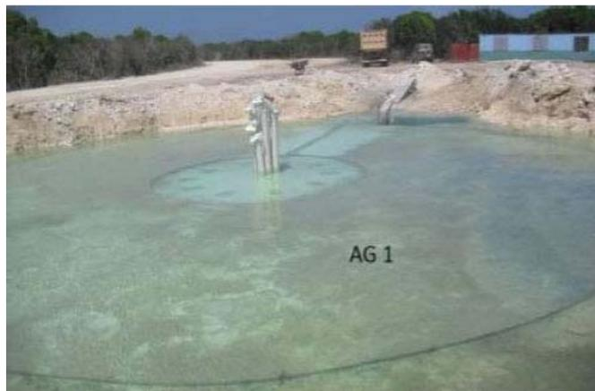
Figura 8. Foto de la excavación de un cimiento de AG del PE La Herradura-1 con agua cubriendo el sello de nivelación
