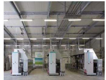
La característica especial de la planta en Mainz es una electrólisis altamente dinámica de presión PEM con hasta 6 MW de potencia. Así, la planta tiene una alta capacidad para conectar a varios parques eólicos y disminuir atascos en la red eléctrica.
