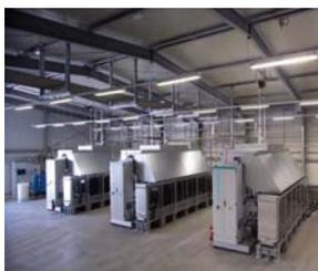
Silyzer es una solución limpia y eficiente para las plantas industriales modernas. Este sistema permite una producción de hidrógeno económica y dinámica, la cual puede servir para muchos procesos. Entre ellos, para la producción de pulpa y papel, también para blindar el gas en la producción de vidrio plano y de gas de síntesis en la industria química. O como un agente de reducción en las plantas metalúrgicas y para endurecer las grasas en la industria alimentaria.
