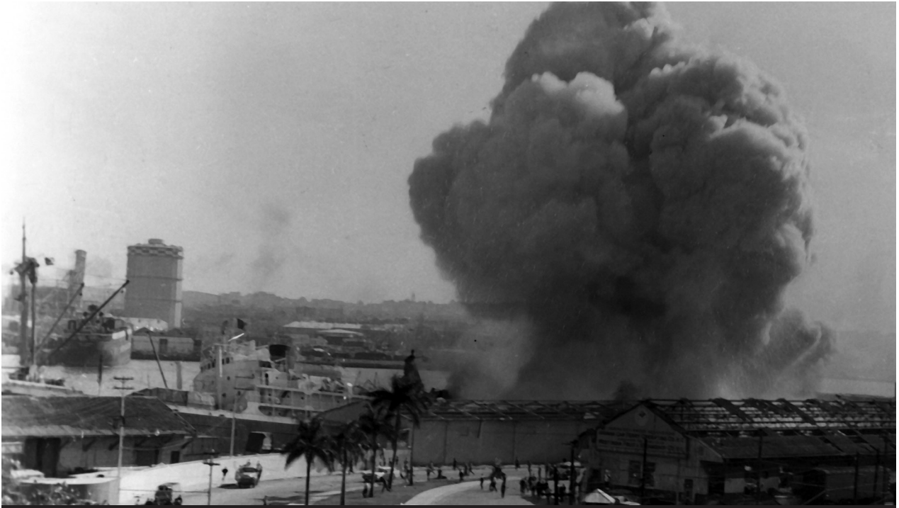
Fotografía tomada al momento de ocurrir la segunda explosión.
