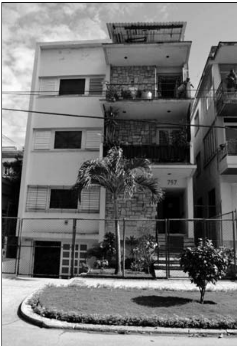
Edificio de la calle 13 No. 757 entre 2 y Paseo, donde la policía de la dictadura apresó a Oscar Lucero. Desde aquí fue llevado al Buró de Investigaciones.
