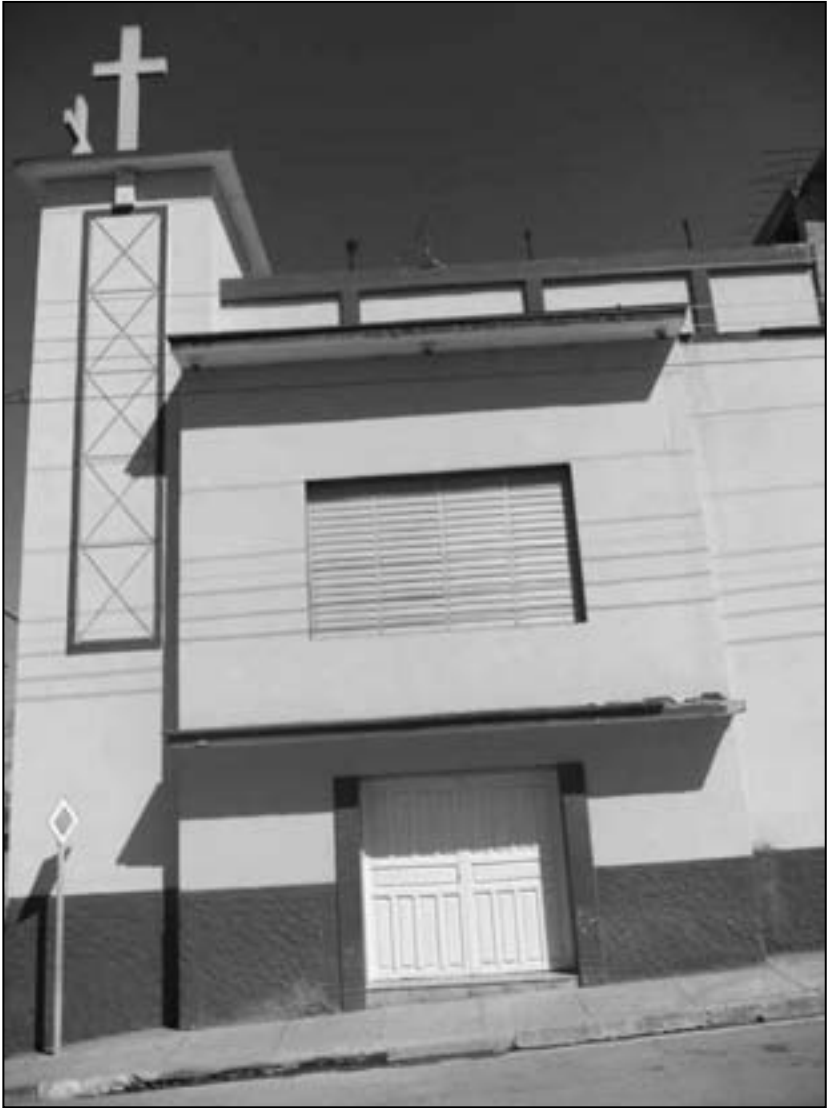
Foto actual de la Iglesia Bautista Sinaí en Palma Soriano donde fue bautizado Oscar.
