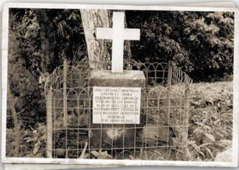
Una de las primeras tarjas construidas.
