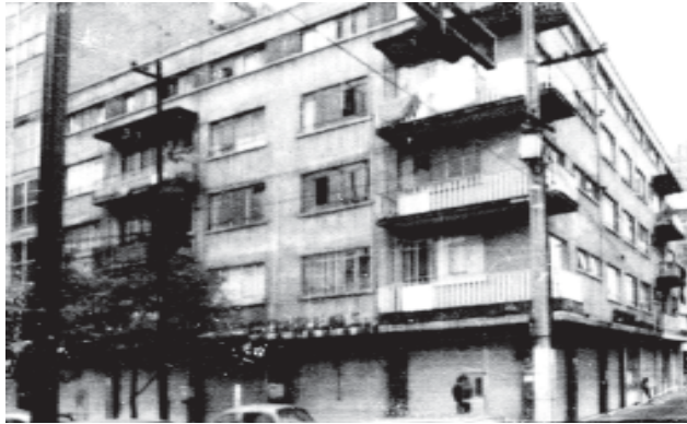
Edificio de Chilpancingo y Bajío, Coyoacán, Ciudad México.
