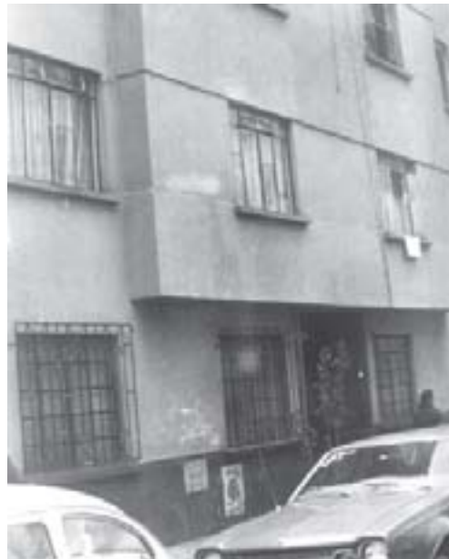
Edificio de Pedro Baranda 18, Ciudad México.
