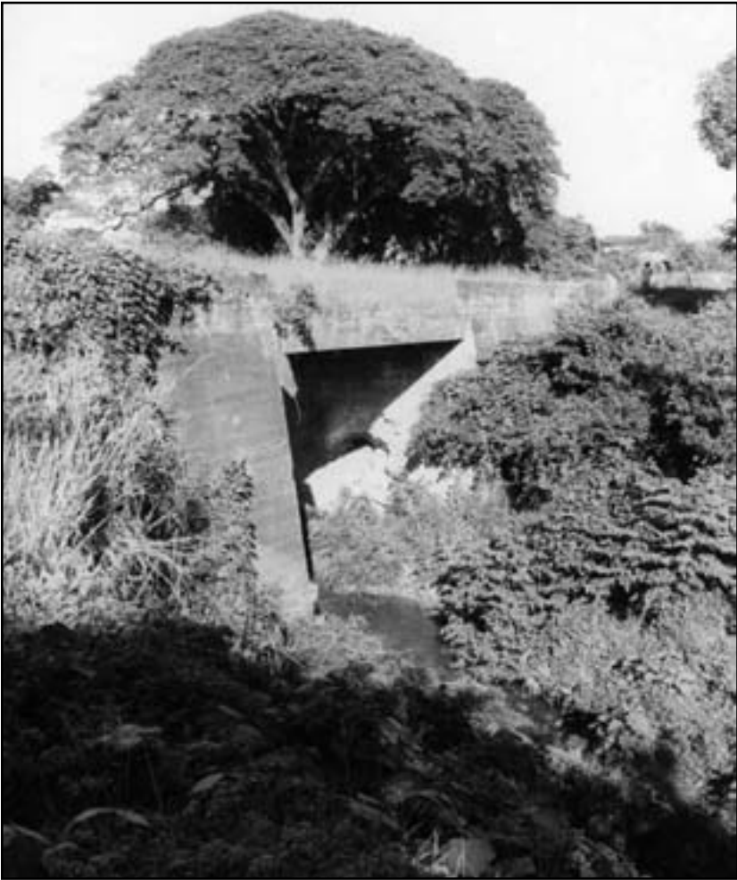
Puente de Monjarás sobre el arroyo Copeinicú.
