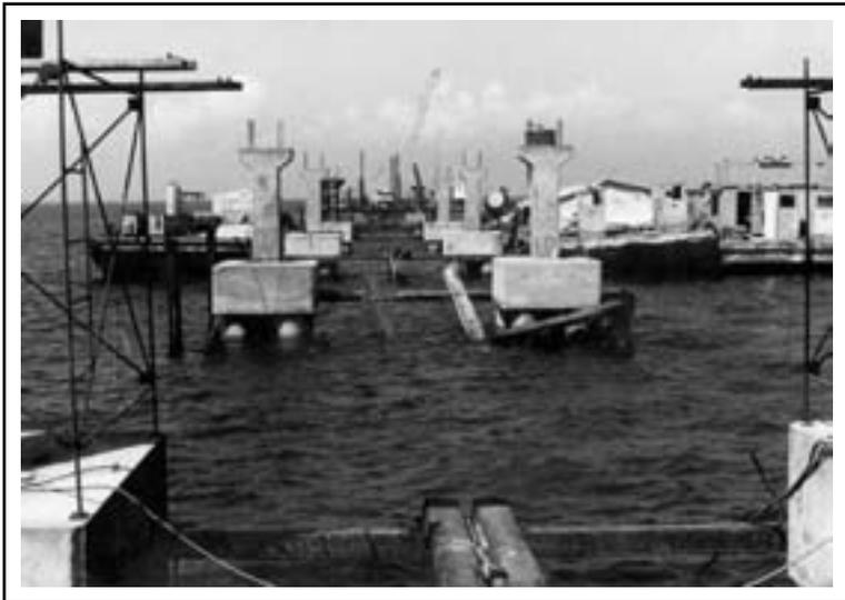
Vista de las piñas de cimentación que enlazan los pilotes con las columnas
