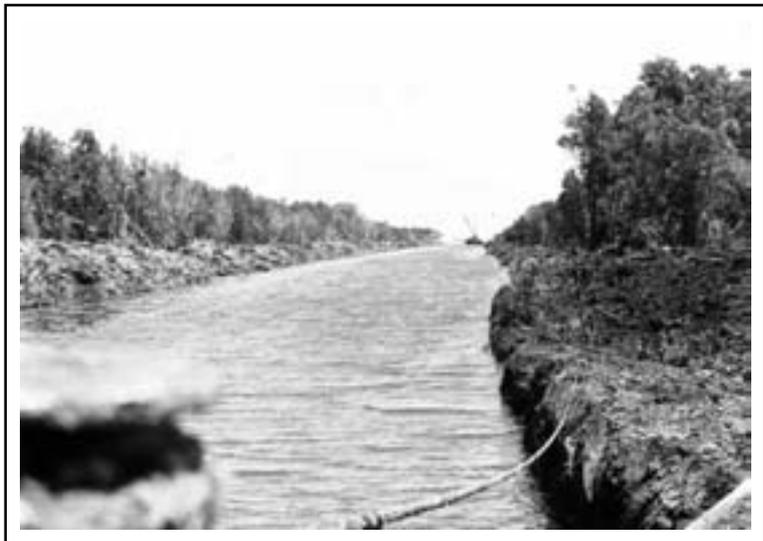
Dragado del cieno para dar inicio a la construcción del vial
