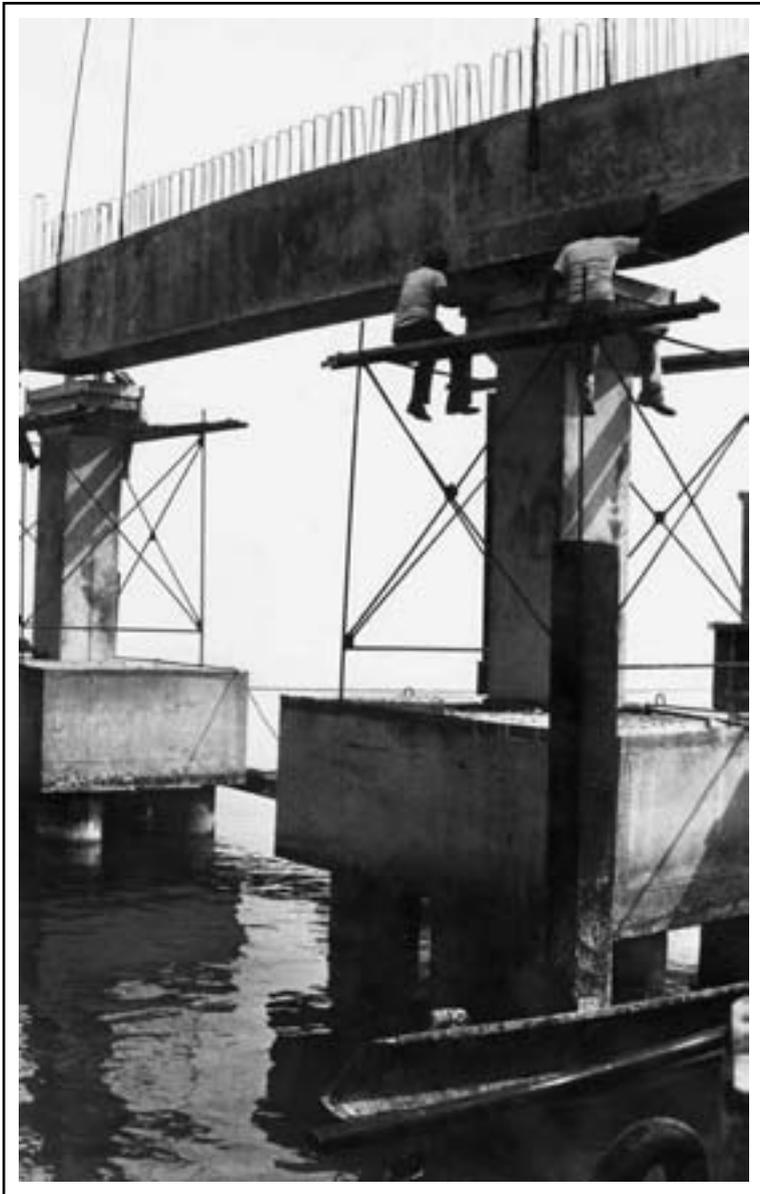
Montaje del primer cabezal de 32 tm y 14,5 m de longitud
