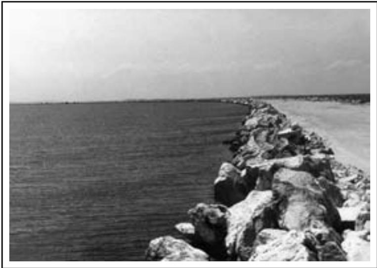
Se observa la coraza protectora de piedras, calculada para vientos con velocidad de 220 km/h, y las amplias curvas
