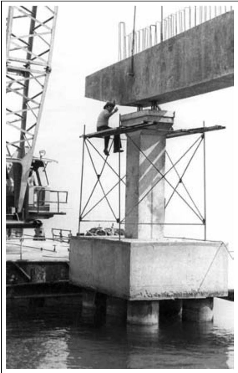
Montaje de prefabricados en el puente del Canal de los Barcos
