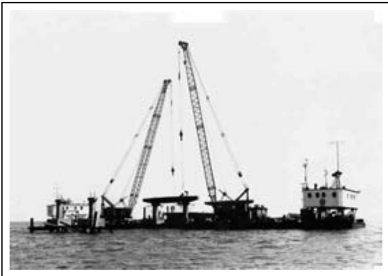
Las grúas maniobran con los prefabricados en el puente del Canal de los Barcos
