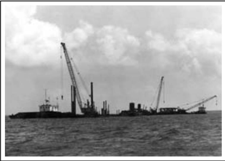
La “isla flotante”, compuesta por tres grúas de 45 tm (toneladas métricas) y cinco patanas de apoyo
