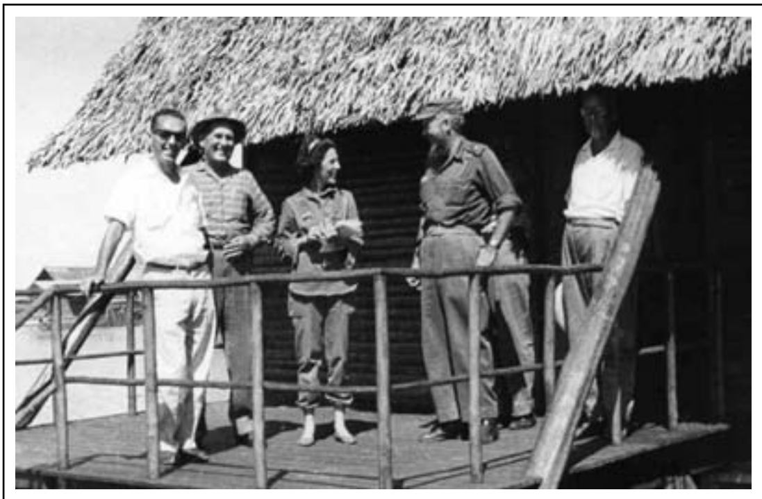
Con el arquitecto Mario Girona Fernández, doctor René Vallejo Ortiz y otros colaboradores durante la construcción del centro turístico de Guamá, ciénaga de Zapata.
