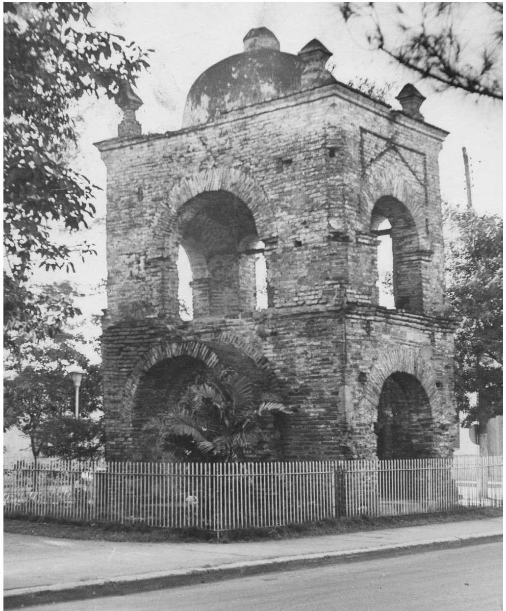
Ruinas del antiguo Cementerio de Bayamo
