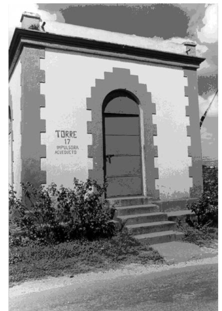
Una de las 3 torres cuadradas o casas de compuertas para el desagüe e inspección del canal de conducción.
