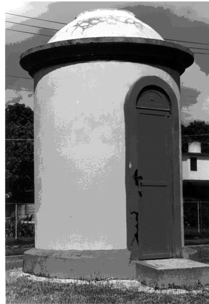
Una de las 24 torres cilíndricas que existen a lo largo del canal de conducción como registros ventiladores.
