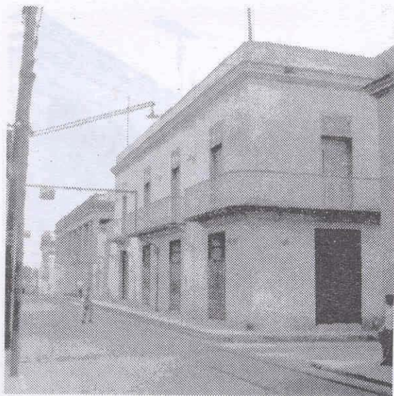
Vista del Liceo de Guanabacoa, en la calle Máximo Gómez. Obsérvense los tubos de hierro para sostener los cables eléctricos del tren y las paralelas en la calle.
