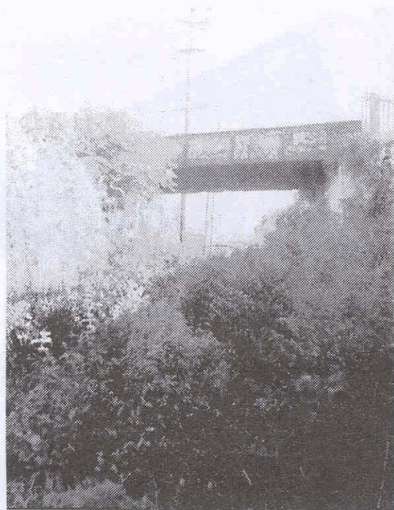
Puente de la calle Barreto. Al fondo el puente de la Calzada de Guanabacoa.
