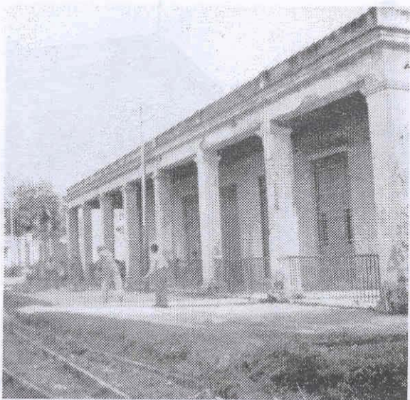
Casa-quinta de Crespo y paralelas del ferrocarril La Prueba al final de la calle de Santo Domingo, Guanabacoa, por donde salía al campo en dirección a Regla.
