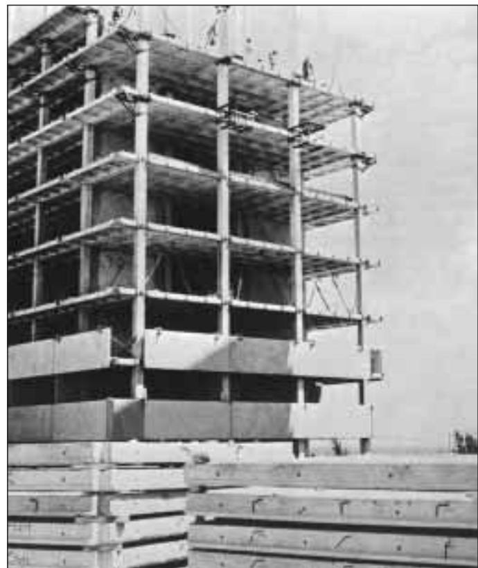
Edificio IMS en construcción
