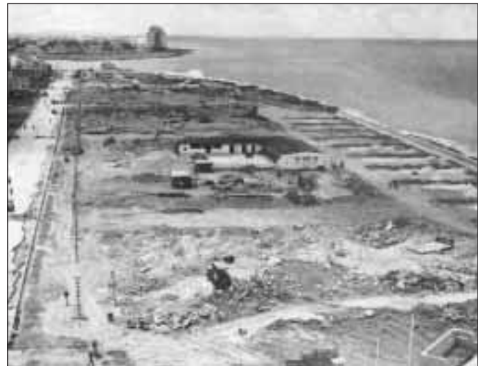
Foto tomada en agosto de 1955 desde la azotea del Palacio de los Deportes, hacia el oeste. Al fondo se divisa, después del río Almendares, el Hotel Rosita de Hornedo, hoy "Sierra Maestra". Obsérvese la construcción de ese tramo del muro del Malecón
