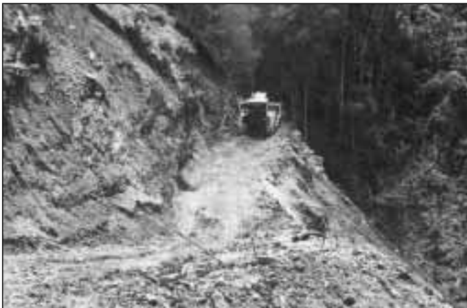
Impresionante foto de un buldózer realizando el corte de una montaña en la carretera Mayarí-Sagua-Moa
