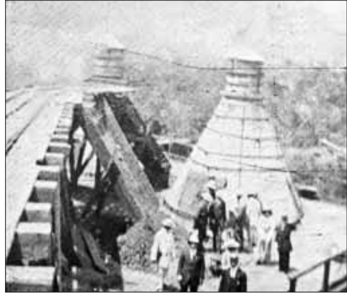
Horno para procesar y separar el azufre del hierro en la mina Daiquirí
