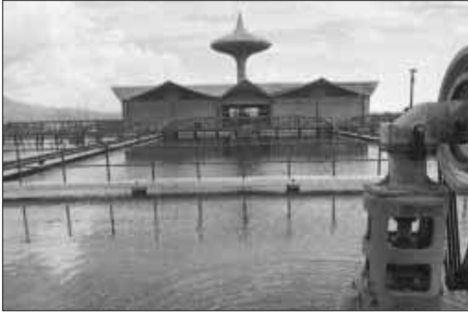
Tanque del acueducto del Santiago de Cuba, al fondo el "Pimpoide"
