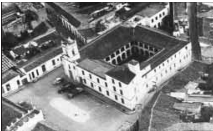
Hospital e iglesia de San Juan de Dios, frente a la plaza de igual nombre. Véase en el extremo inferior izquierdo, la casita de dos plantas que se ilustra en la siguiente columna
