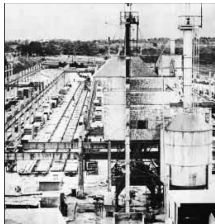
Planta "José Martí" de prefabricado general en la Avenida de Rancho Boyeros
