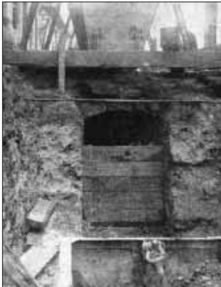
Cloaca vieja, encontrada cuando las obras del alcantarillado en 1913
