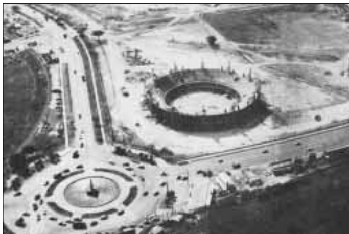
Vista aérea de la construcción de la Ciudad Deportiva en 1956. En primer plano, la fuente luminosa en la rotonda
