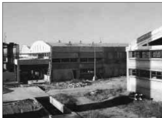
Frigorífico en construcción
