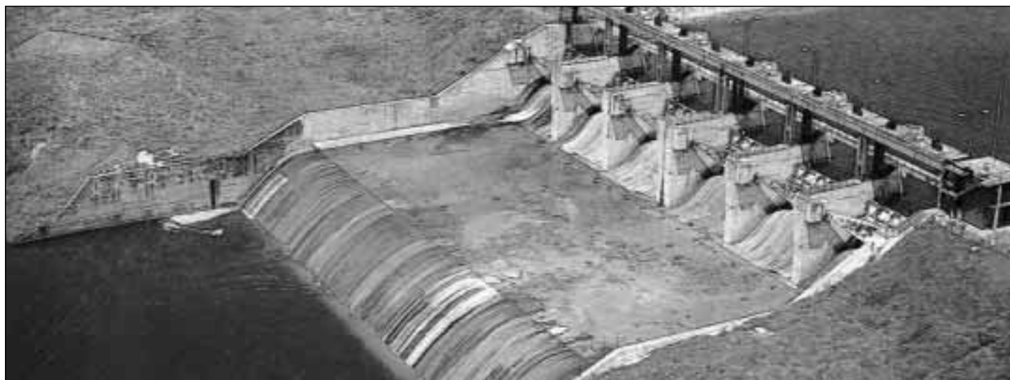
Vista aérea del aliviadero de la Presa Zaza
