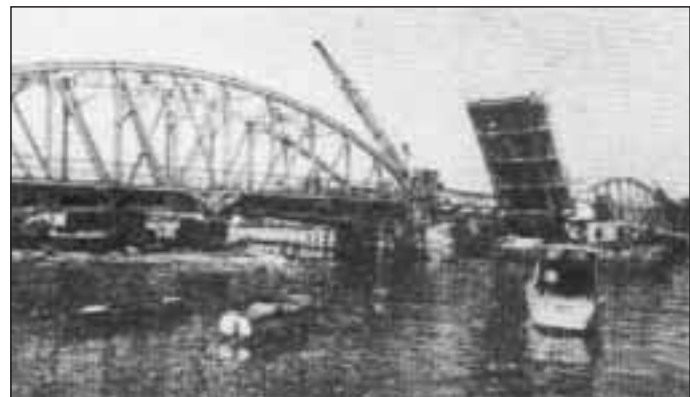
Foto del puente de "Pote" levantado para dar paso a un yate
