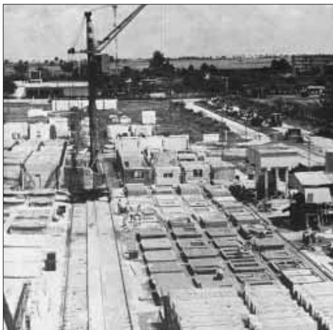
Fábrica de elementos prefabricados sistema Gran Panel IV
