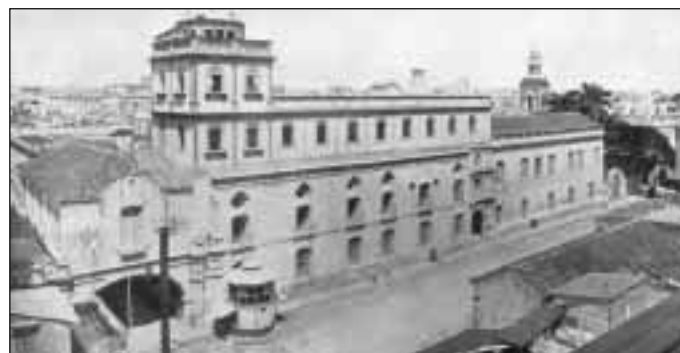
Convento e Iglesia de Belén. A la izquierda, el “Arco de Belén” sobre la calle Acosta
