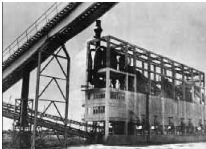
Trituradora de la RDA montada en Arriete
