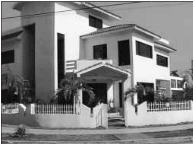
Vivienda construida por el Sistema Horm-EPS, en la calle 3. a A y 38 en el Reparto Miramar
