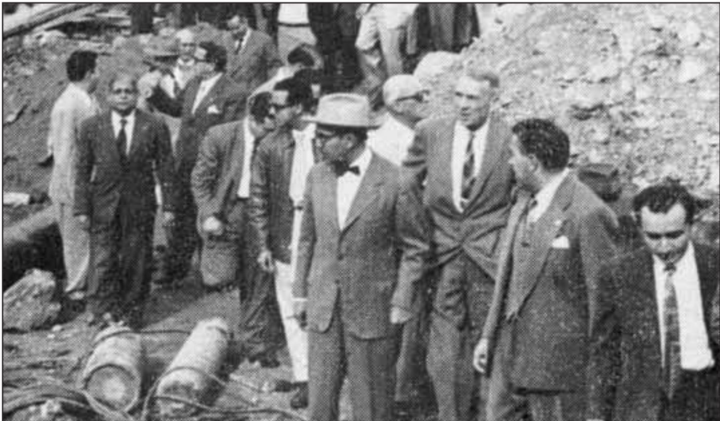
Al centro, con sombrero, el eminente científico cubano de la construcción, ingeniero José Menéndez Menéndez , visita las obras del túnel de la calle Línea
