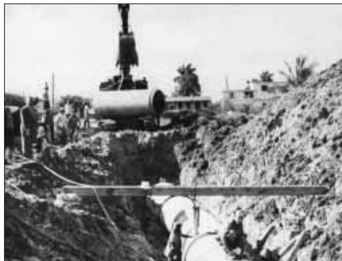
Segunda Ampliación del Acueducto de Albear
