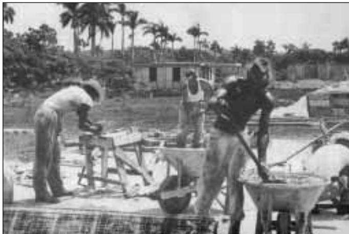
Grupo de trabajadores construyendo sus propias viviendas
