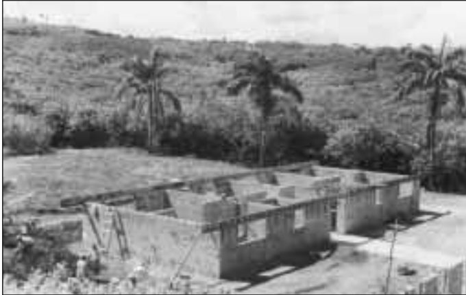
Hospital de montaña en construcción en la provincia de Oriente en 1959
