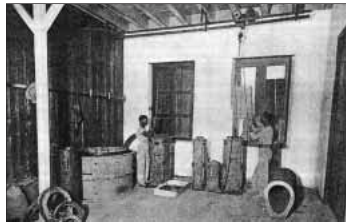
Fábrica de tubos de alcantarillado El Almendares
