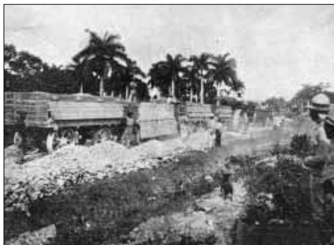
Equipo llamado "Troy" por los norteamericanos, usado para el transporte de áridos, en la construcción de la carretera de Pinar a Luis Lazo, en el año 1907
