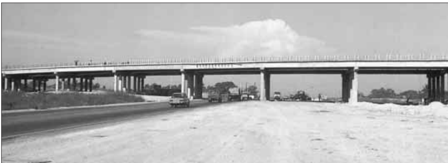
Construcción de la autopista "Este-Oeste"
