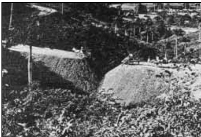
Construcción de la carretera de Pinar a Luis Lazo en 1907, donde se realizaba el movimiento de tierra con carretones de caballos
