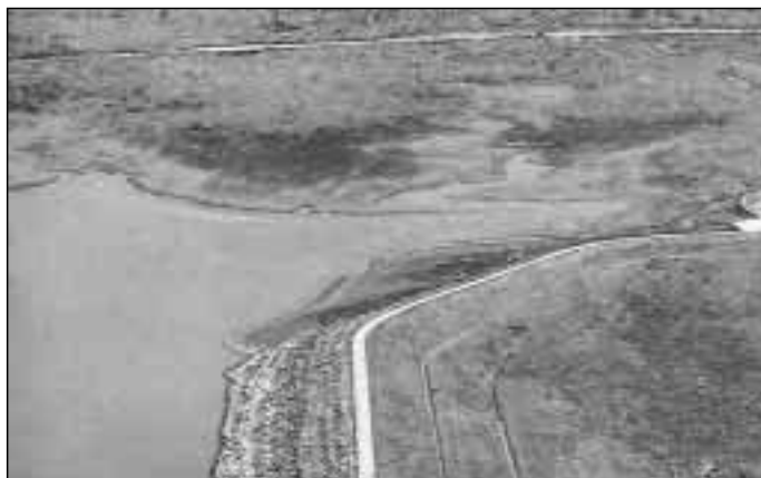
Vista aérea de la cortina de la presa La Yaya
