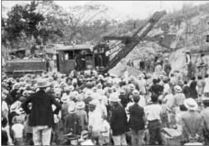
Acto simbólico de inicio de las obras de la Carretera Central, celebrado en San Francisco de Paula con la presencia del presidente Machado
