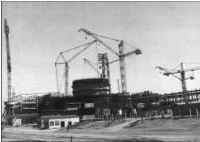
Construcción de la Central Electronuclear
