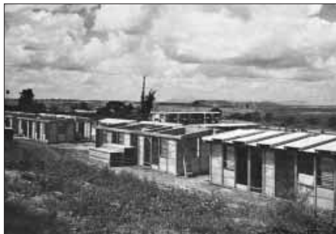
Comunidad rural construida con el Sistema Sandino
