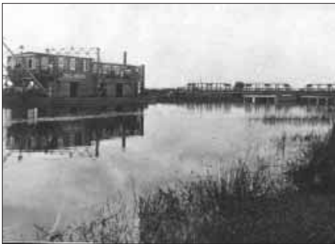
Draga América trabajando en el Canal de Roque. Al fondo, el puente de "Las Carolinas"
