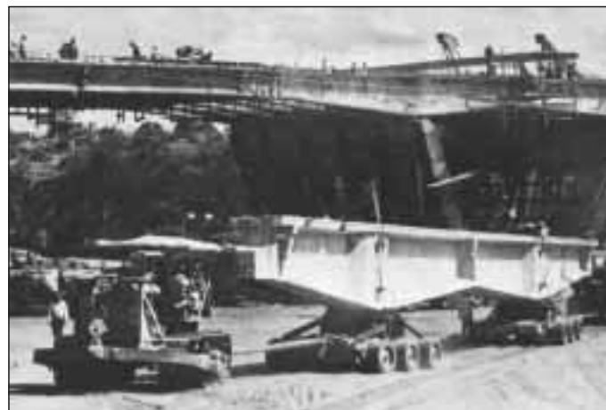
Reconstrucción del puente sobre el río Bayamo después del "Flora"
