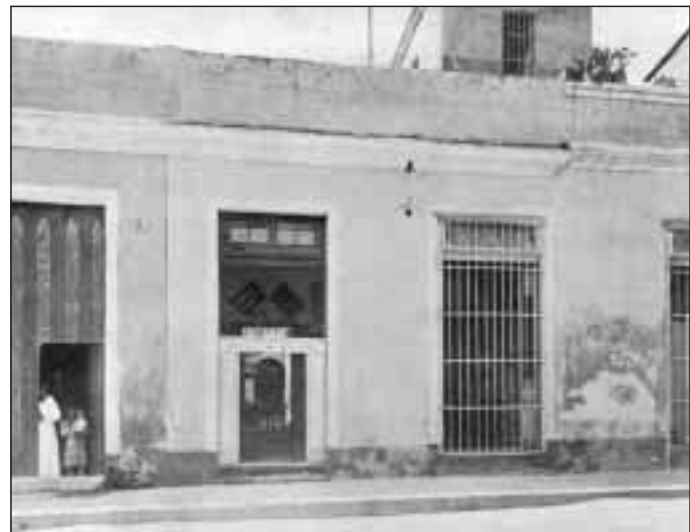
Escuela Pública en una vivienda
