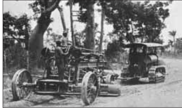
Niveladora tirada por un tractor trabajando en el tramo correspondiente a la provincia de Pinar del Río
