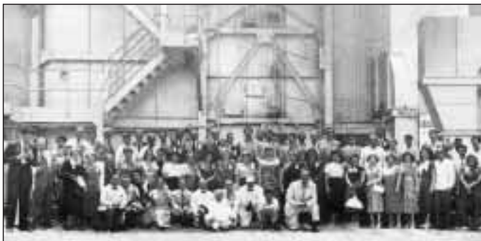
Excursión de la Sociedad Cubana de Ingenieros a la termoelectrica de O'Bourke
