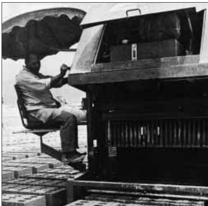
Máquina Multiblock en operación
