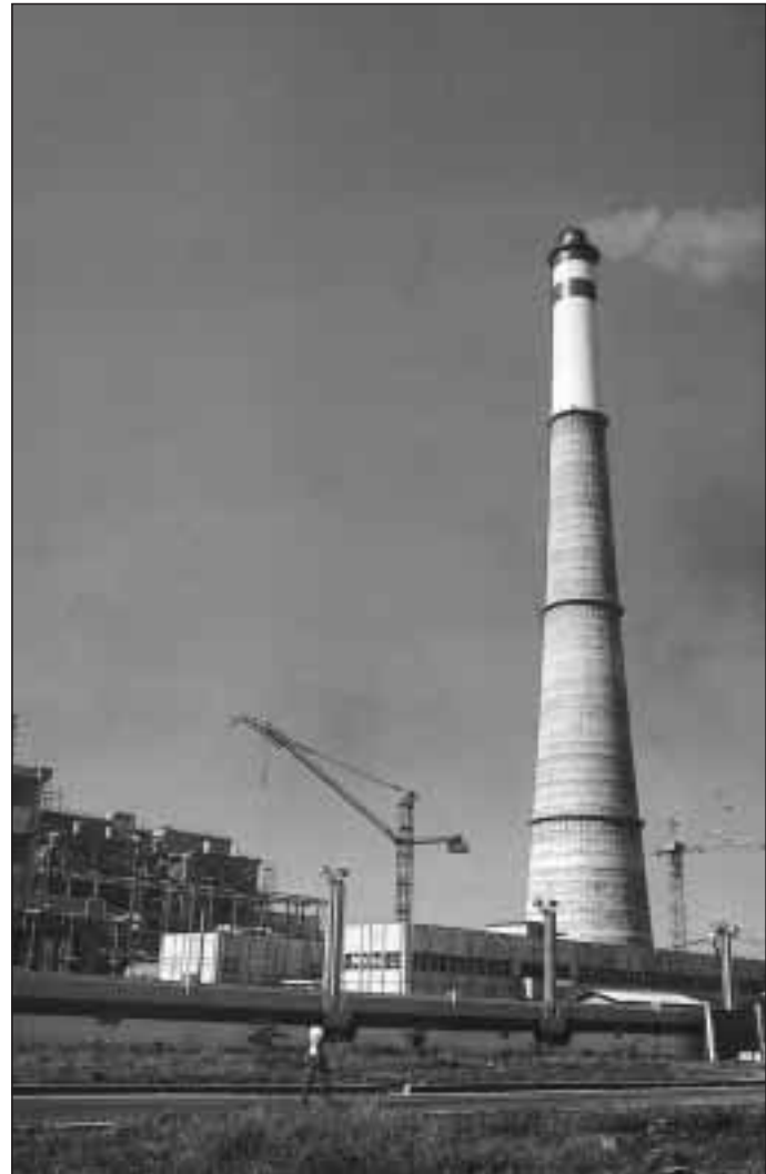
Termoeléctrica en Santa Cruz del Norte
