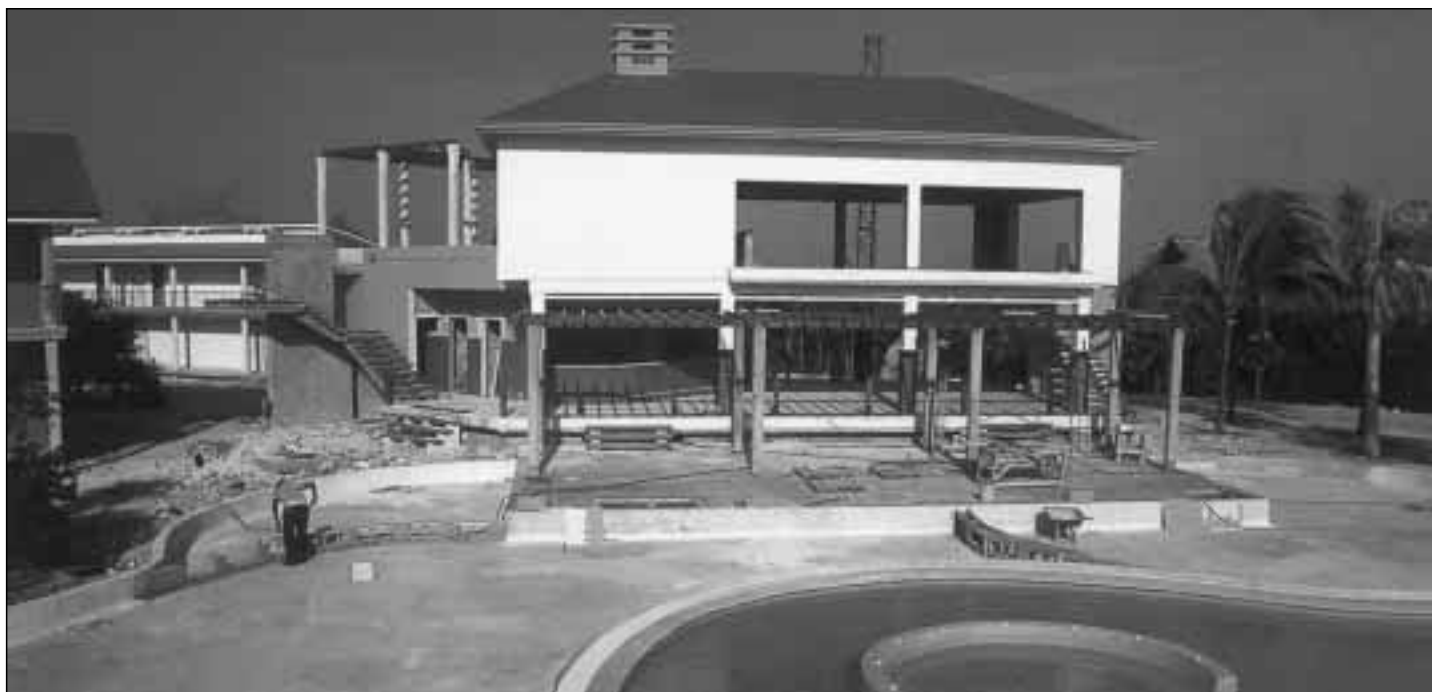
Foto del hotel Arena Real en construcción
