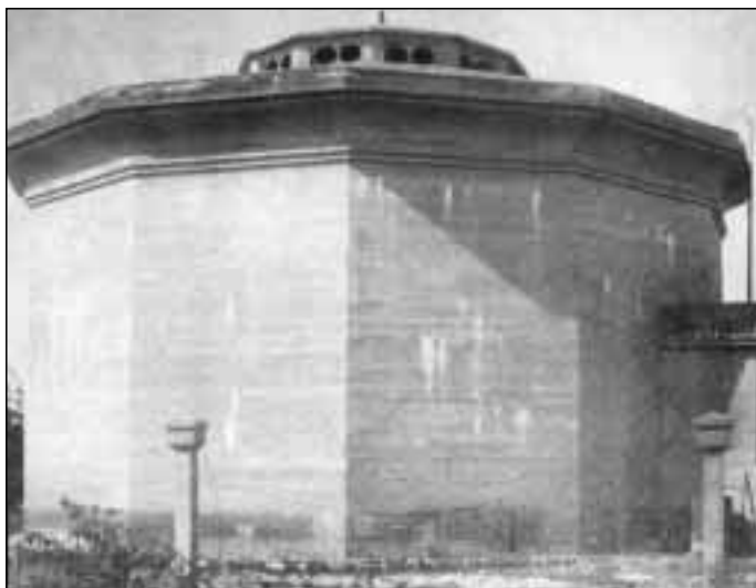
Tanque del acueducto de Guanabacoa
