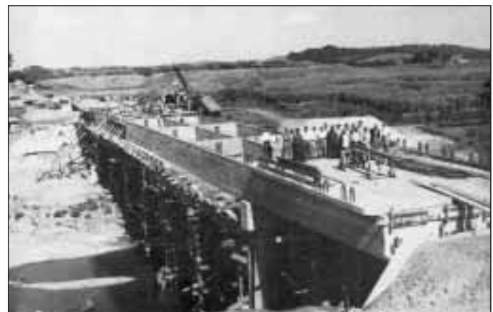
Visita de la Sociedad Cubana de Ingenieros al puente sobre el río Arimao
