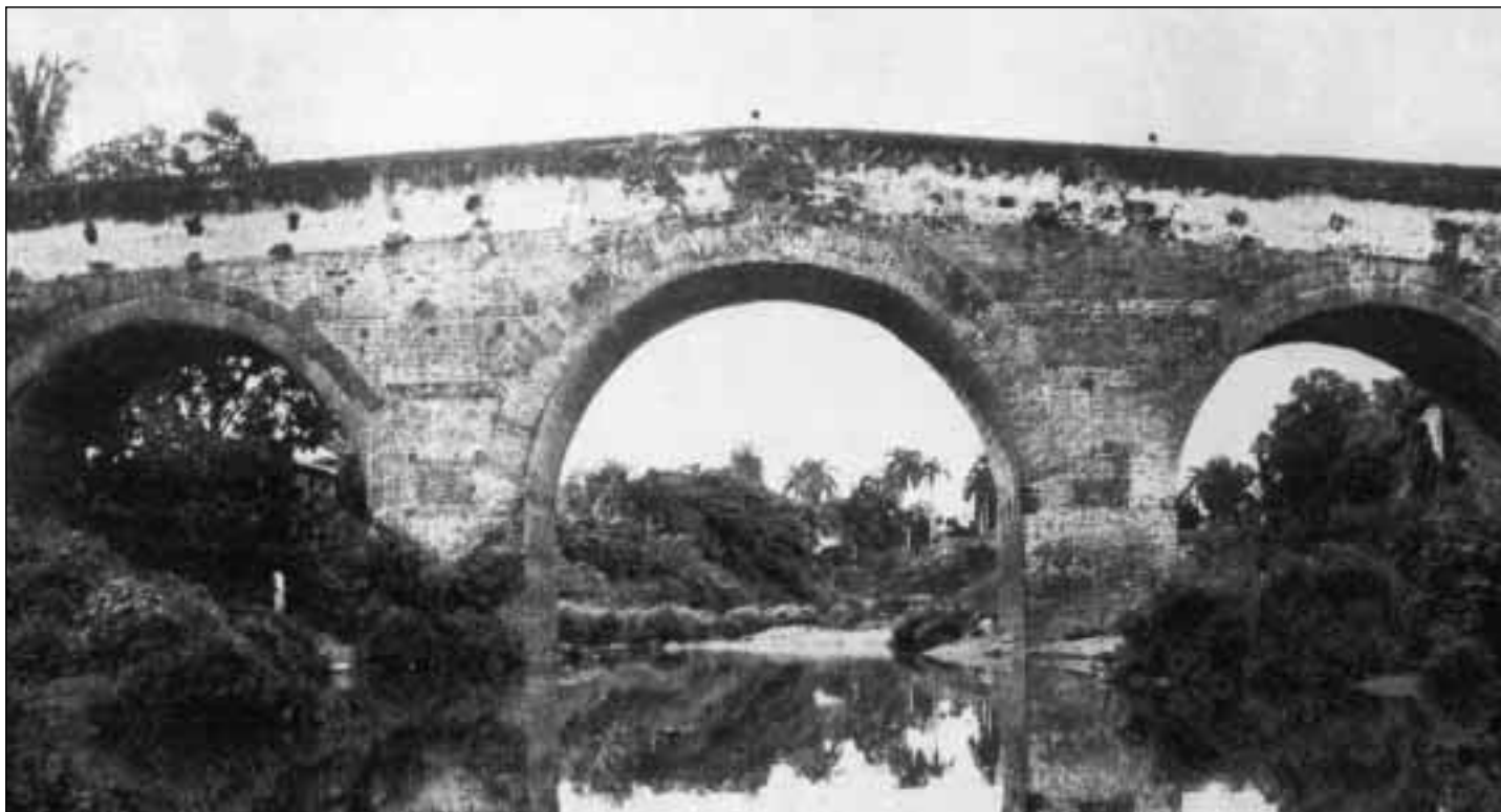
Foto del puente sobre el río Yayabo
