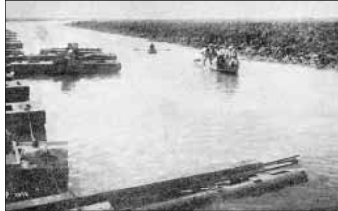
Visita de la Sociedad de Ingenieros en el año 1919 a las obras del Canal de Roque
