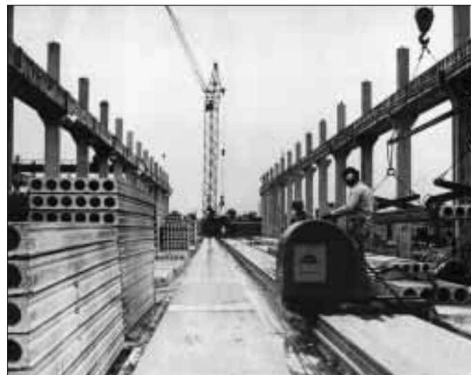
Producción de losas Spiroll en la planta de prefabricado José Martí en la Avenida de Rancho Boyeros
