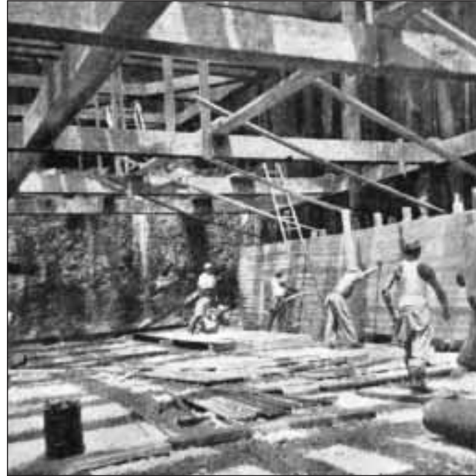
Encofrando el techo del túnel, 11 metros bajo el río
