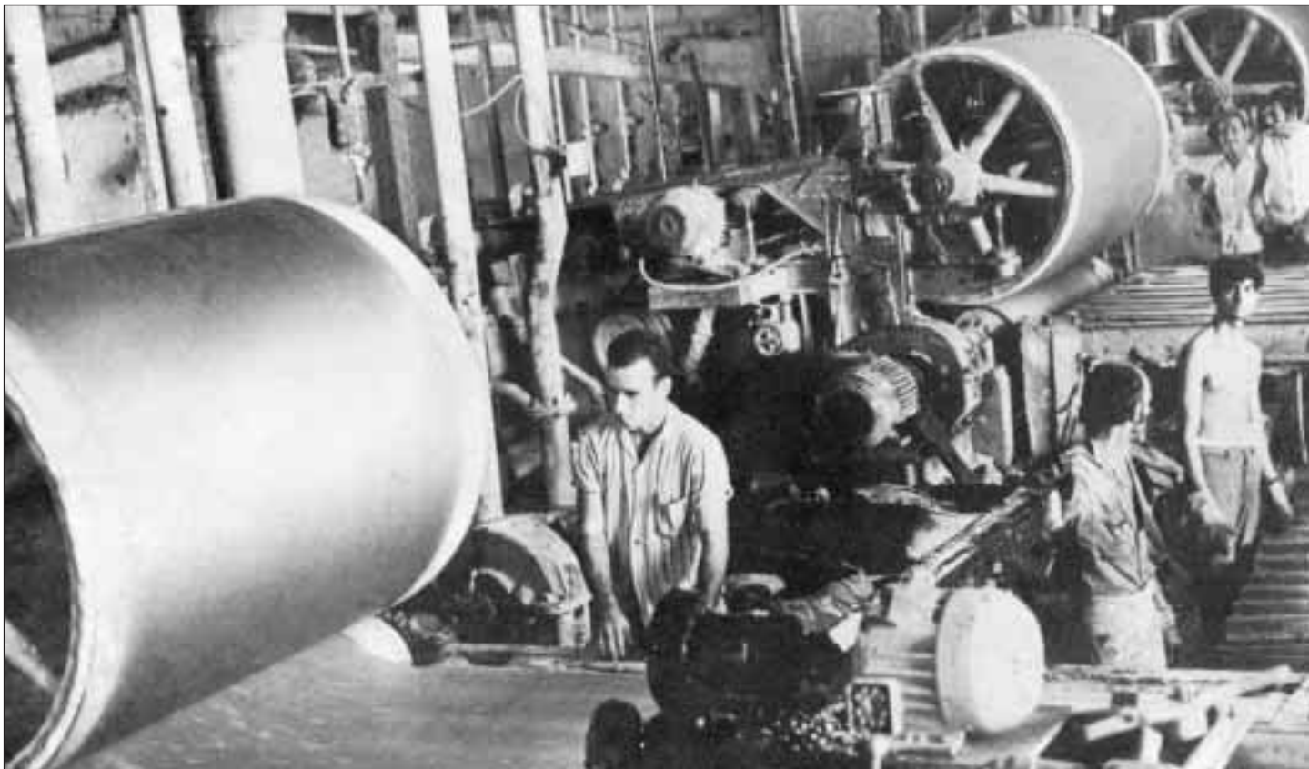
Foto de las laminadoras en el año 1964; al fondo, el segundo de derecha a izquierda, es el autor de este libro, en aquella época Director de la Empresa de Asbesto Cemento
