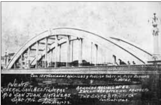
Puente Sánchez Figueres sobre el río San Juan
