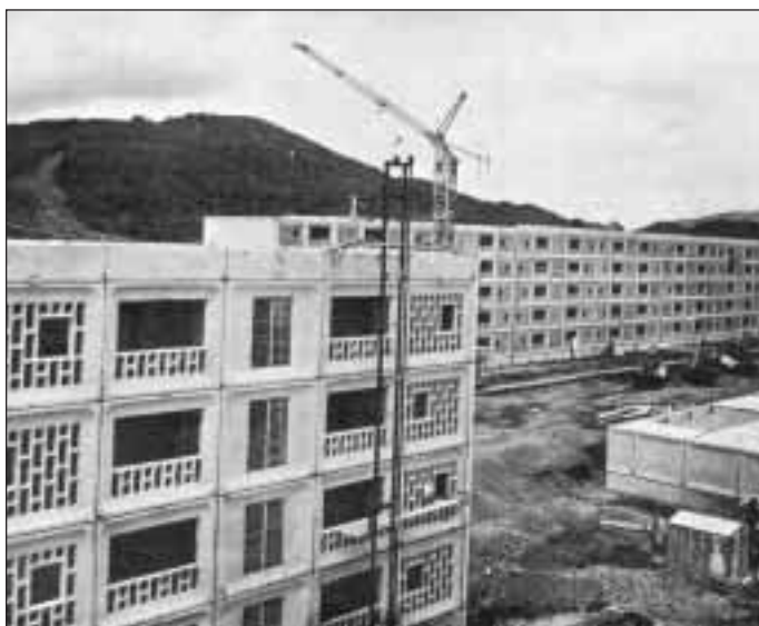
Montaje de edificios de gran panel soviéticos
