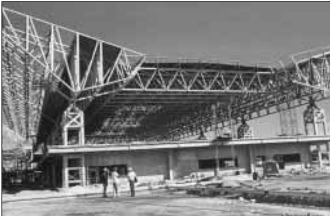
Construcción del Edificio Principal del Aeropuerto José Martí
