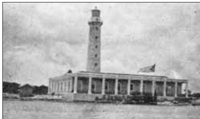
Faro de sillería construido en Cabo Cruz en 1871
