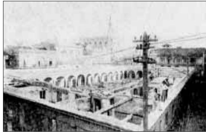
Derribo del Mercado de Cristina en la Plaza Vieja
