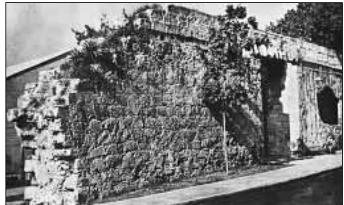
Tramo de la muralla conservado al Sur de la calle Egido
