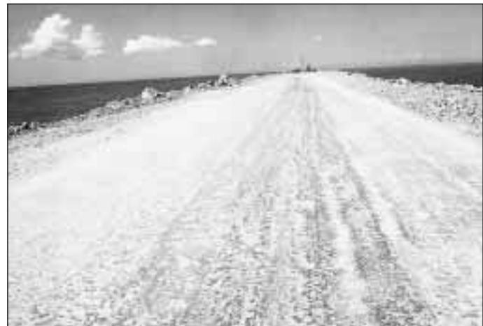
Pedraplén cuando estaba en construcción a Cayo Coco
