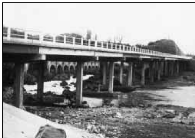
Puente sobre el río Queve en la carretera Gabela - N'Gunza. En la foto de la izquierda se muestra como quedó destrozado después de la guerra; a la derecha se ve el nuevo. Nótese los arcos del viejo puente detrás. Tiene 252 metros con 18 luces
