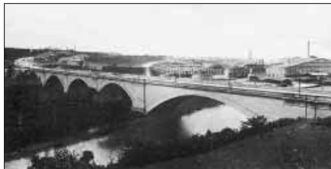
Puente "Asbert" en la calle 23; al fondo, la fábrica de cemento "Almendares"
