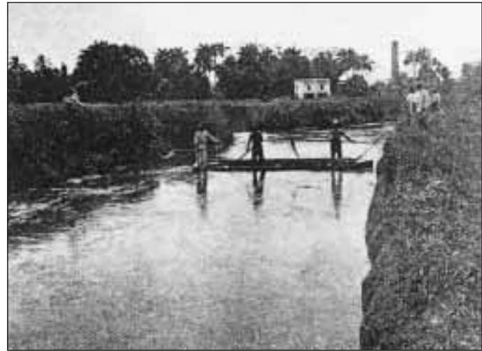
Foto tomada de la Zanja Real en 1916, el pequeño edificio al fondo era la casa de compuertas
