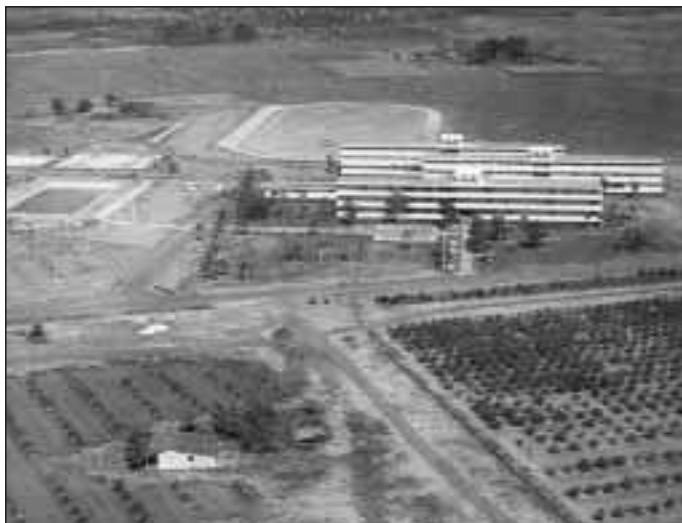
ESBEC en construcción en la zona de Bayamo, al frente los terrenos cultivados y a la izquierda y al fondo campos deportivos
