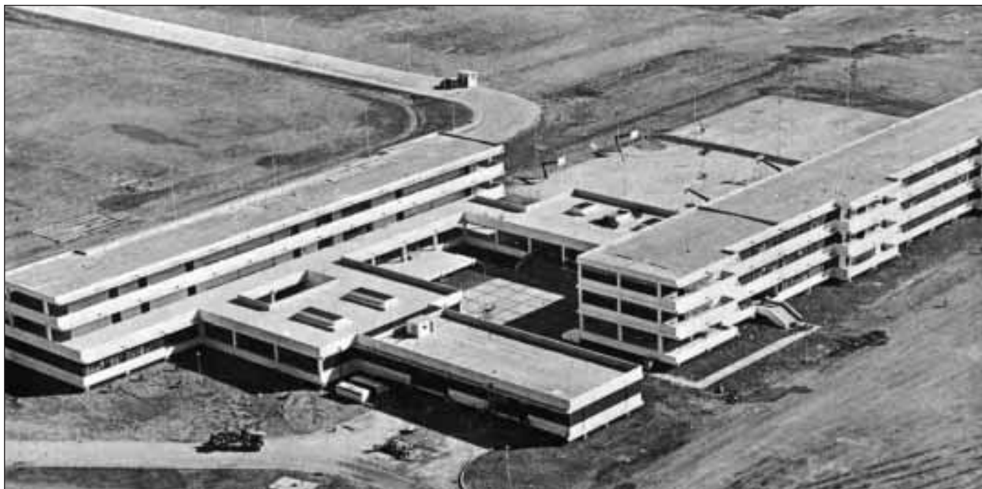
Foto aérea de la Escuela Secundaria Básica rural en la zona norteña de Montpelier, con capacidad para 250 alumnos internos; donada y construida por Cuba en Jamaica.
