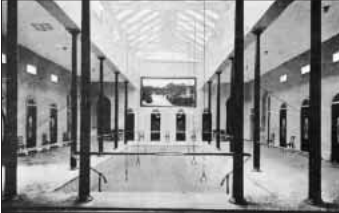
Sala de hidroterapia y electroterapia instalada en 1905
