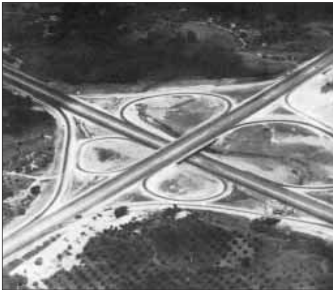
Intercambio de la Autopista Nacional y el Primer Anillo de La Habana
