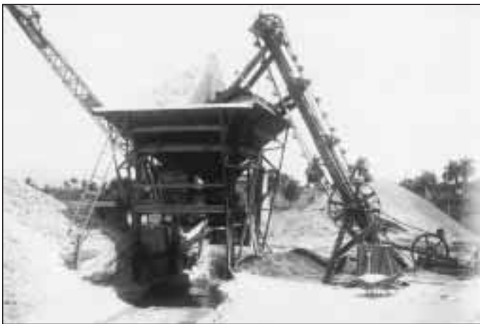
Lavadora y cernidora de arena utilizada en la construcción de la Carretera Central en el río Bayamo
