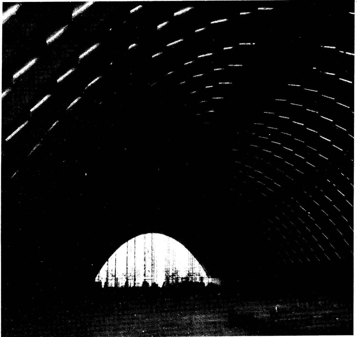
Almacén N° 1 de azúcar a granel, cubierto por arcos parabólicos. Su capacidad es de 90 000 toneladas métricas
