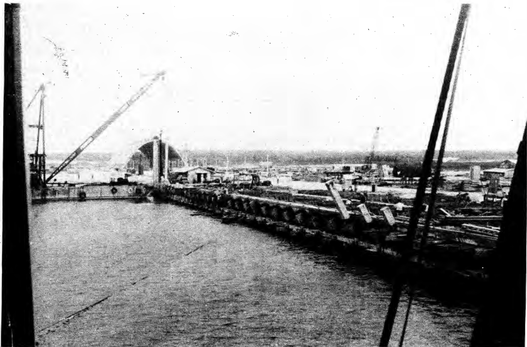
Ya está concluida la primera etapa de la construcción del espigón del muelle: longitud 226 metros por 24.35. En la segunda etapa, su largo será de 306 metros
