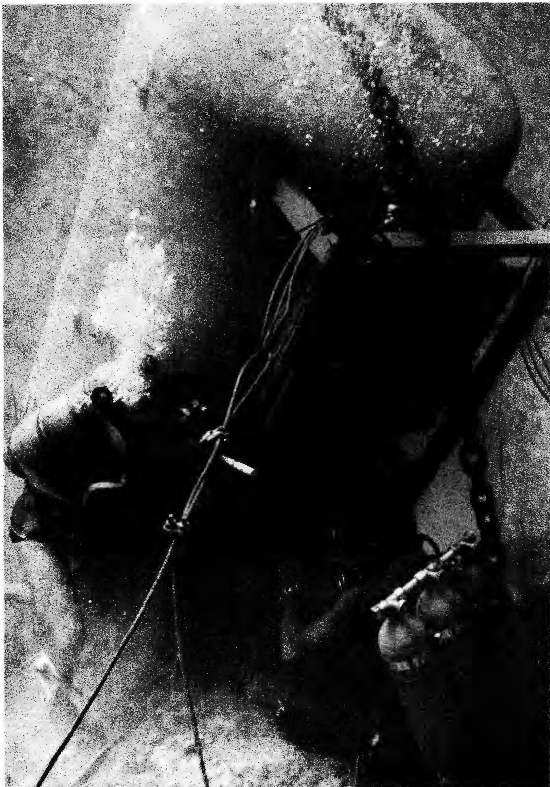
Los buzos aseguran la casa-tanque mediante cables y pesados railes de acero
