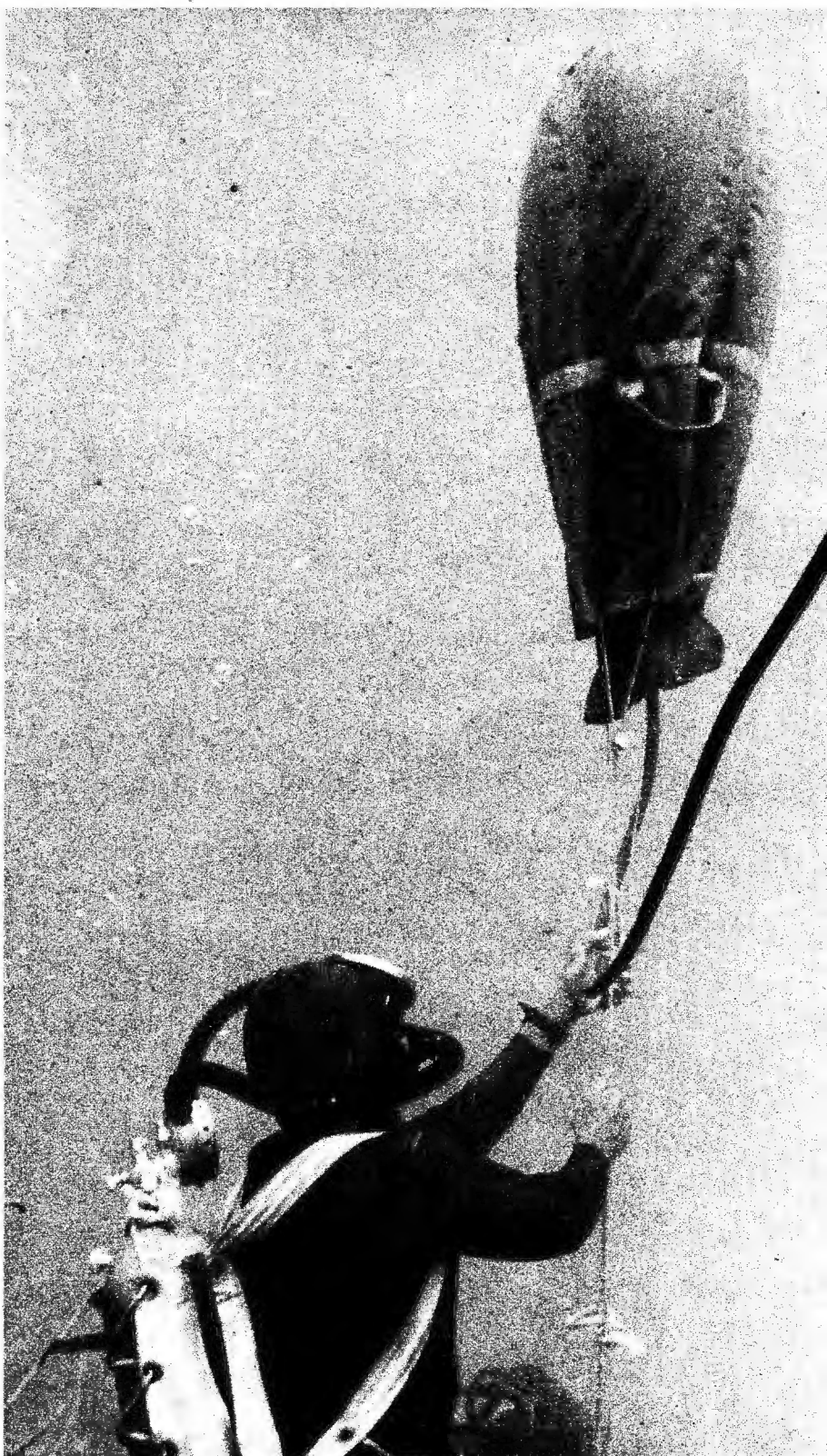
La bolsa se llena con el aire de un cilindro que está también bajo el agua. Esta bolsa ayuda al buzo a transportar los grandes rieles.
