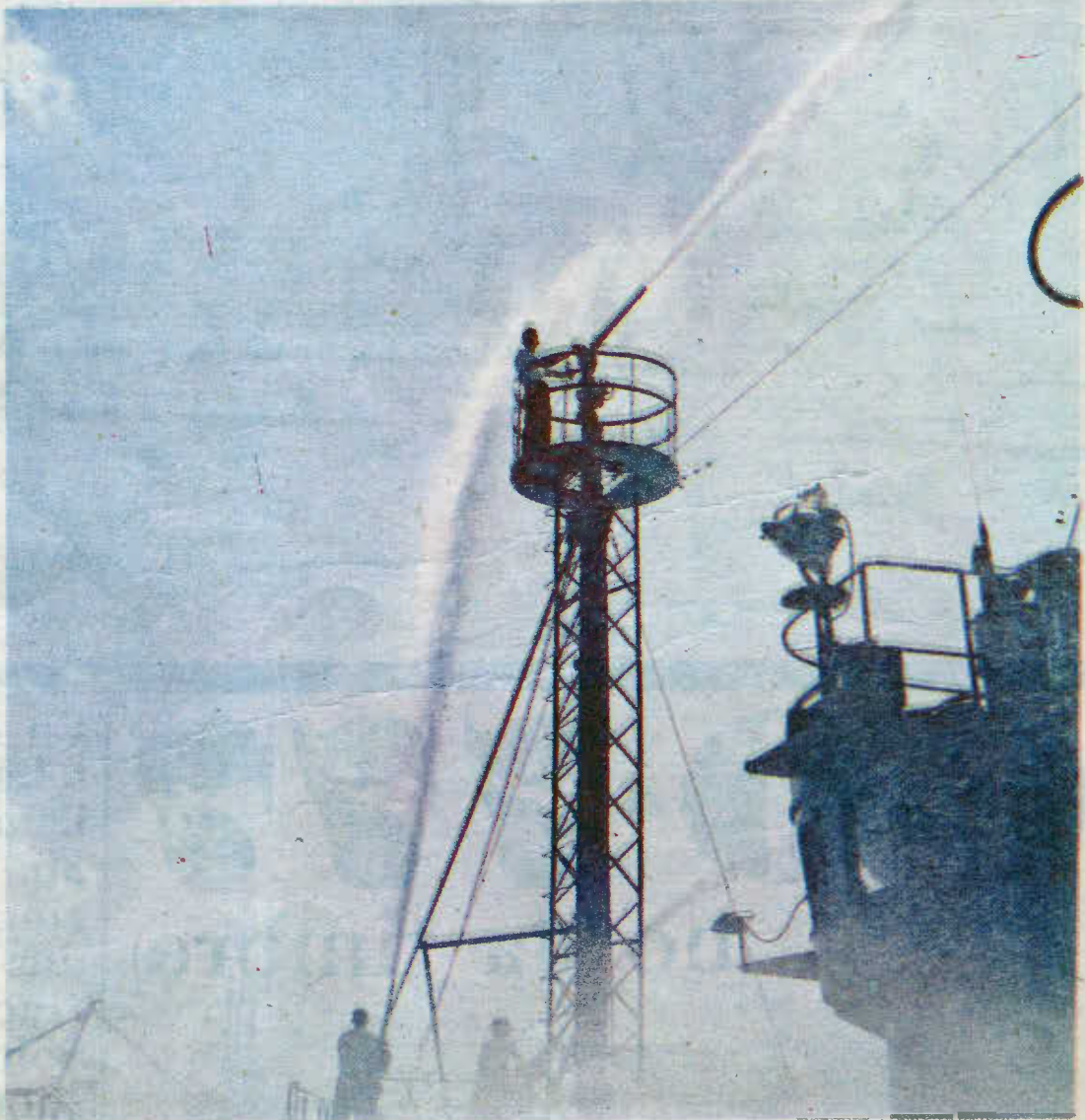
Los monitores situados en torres de diferentes alturas facilitan la labor de extinción
