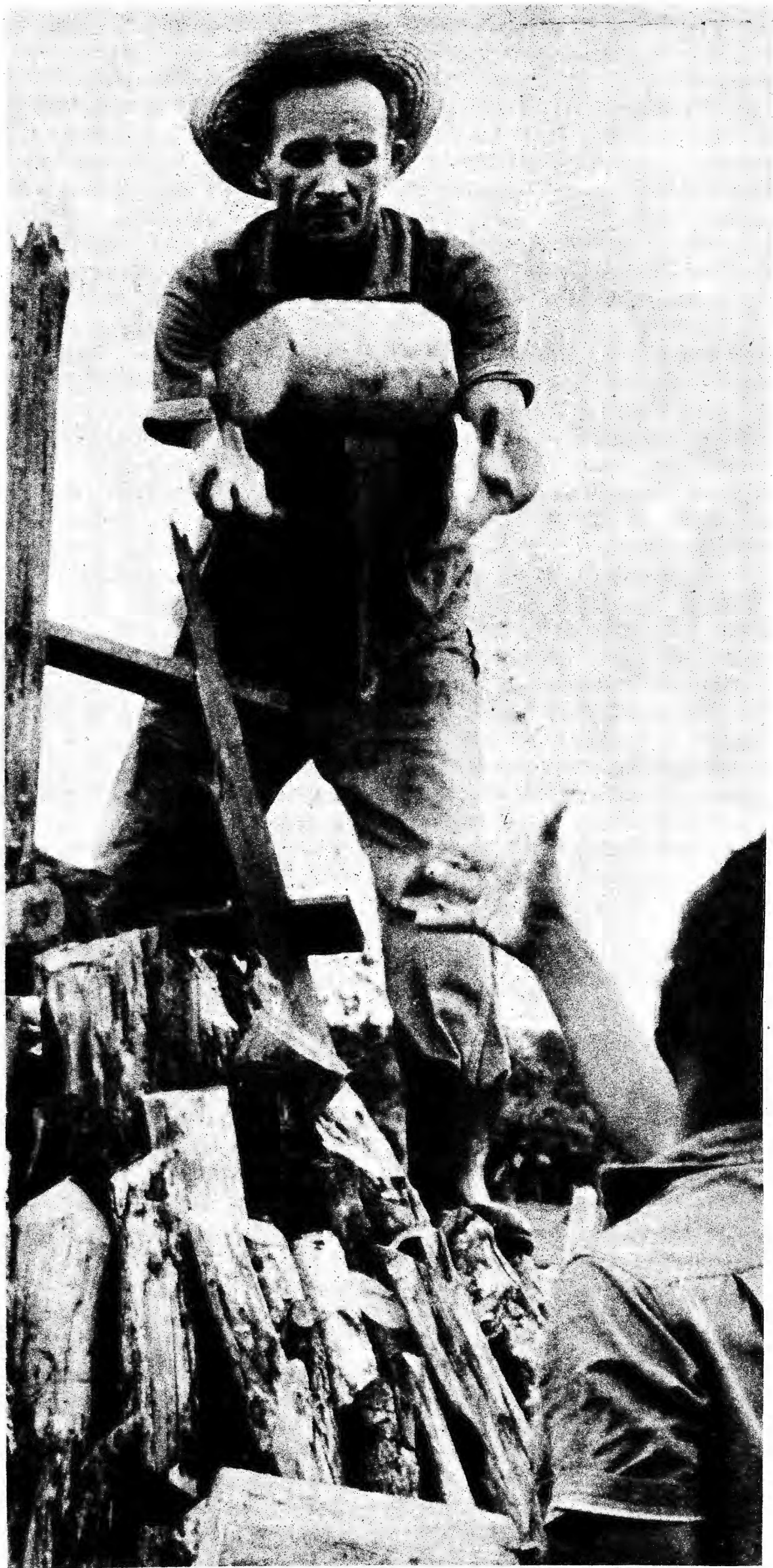
En las granjas se realizan diversas labores: construcción de un horno de carbón
