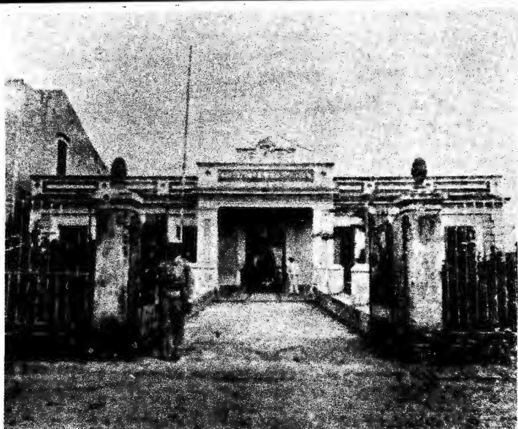
CUARTEL MUNICIPAL DE BOMBEROS
