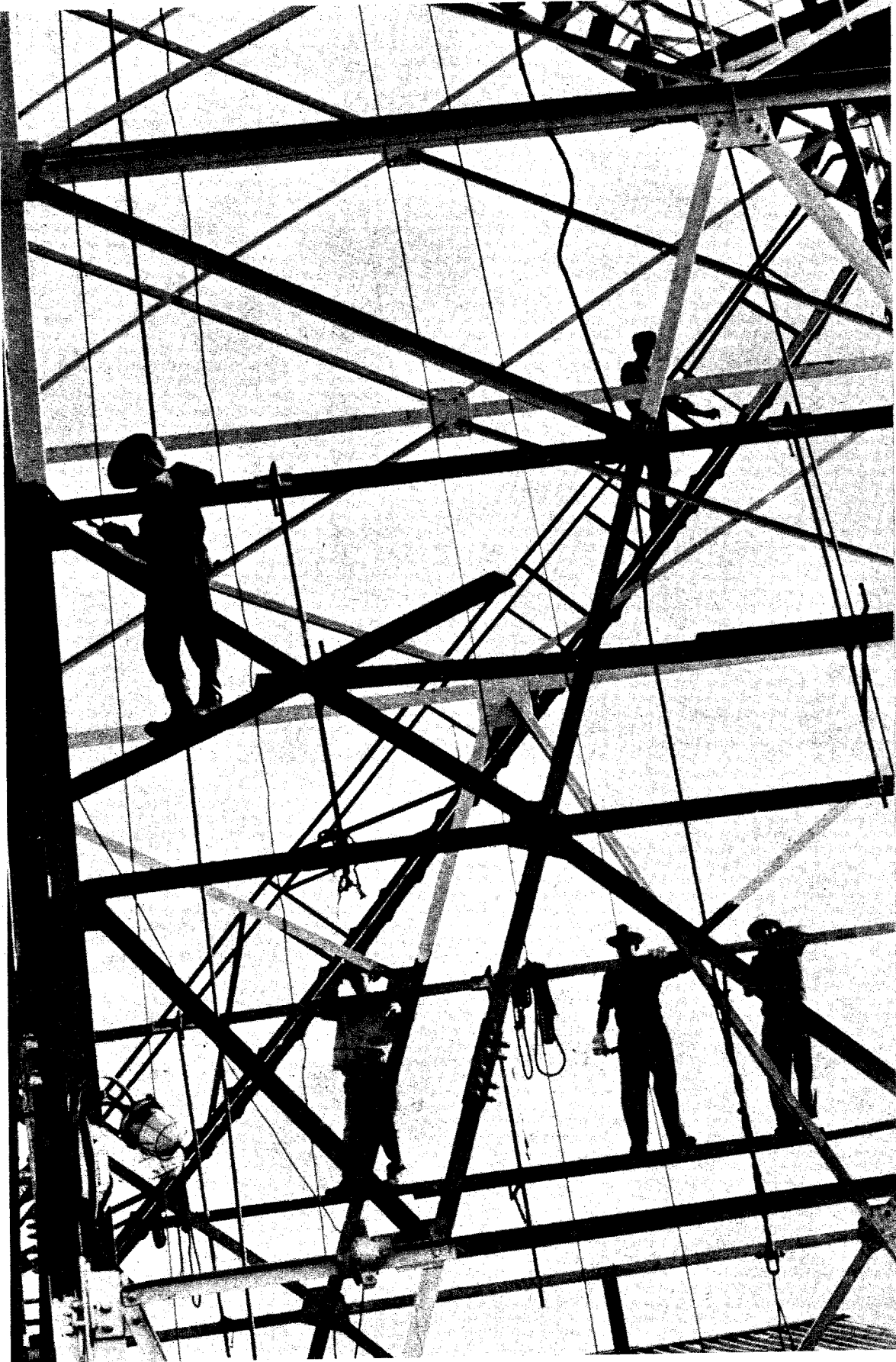
LA BRIGADA —7 HOMBRES— REPARA LA PINTURA DE LA TORRE DE CAYO FRANCES
