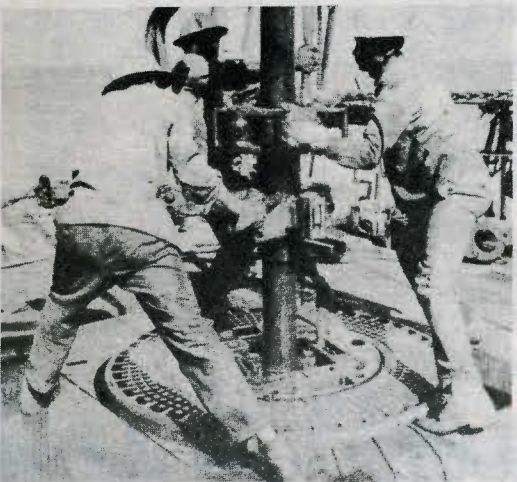
EL APAREJO CARGA LOS TUBOS HASTA LA BOCA DEL POZO. AHI LOS INTRODUCEN LOS PERFORADORES
