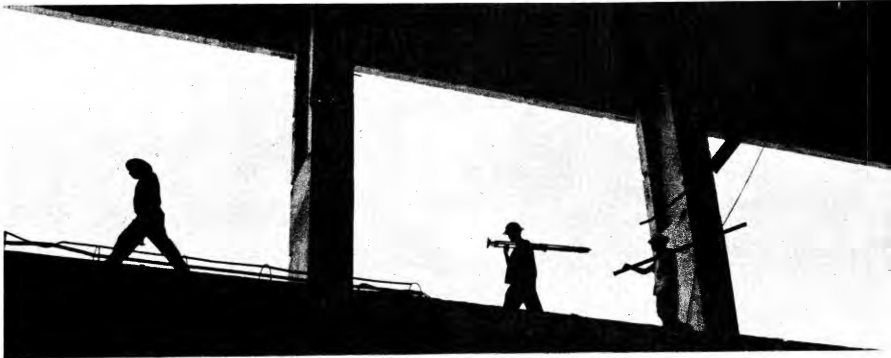
FUTUROS VENTANALES DEL EDIFICIO CENTRAL
