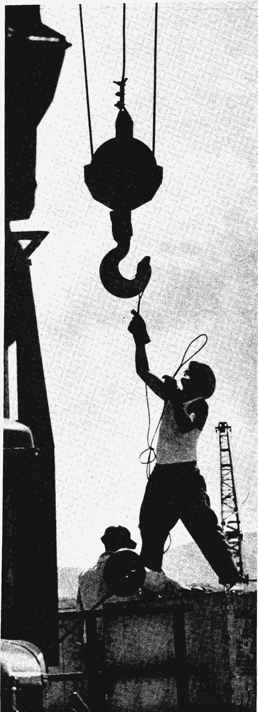
LLEGAN NUEVOS EQUIPOS PARA LA INMENSA OBRA
