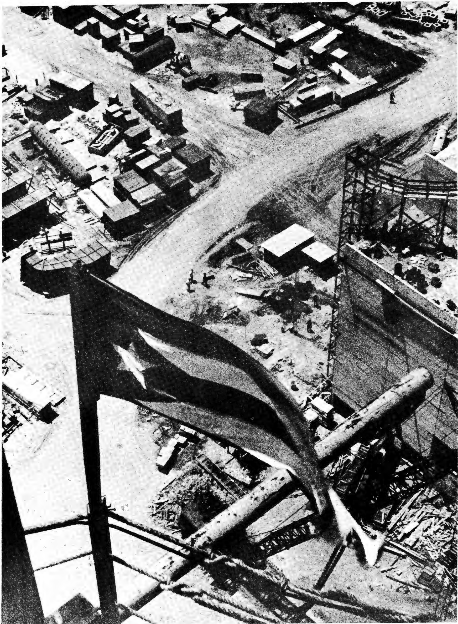
A 80 METROS DE ALTURA, EN LA CUSPIDE DE LA CHIMENEA. ABAJO: INSTALACIONES Y EQUIPO RECIEN LLEGADO A LA TERMOELECTRICA
