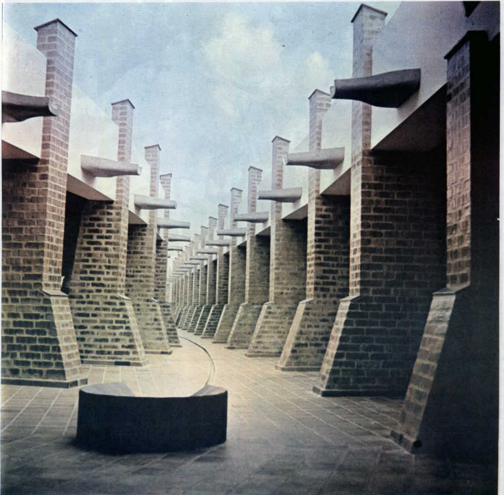
CALLE QUE UNE LA ENTRADA DE LA ESCUELA DE ARTES PLASTICAS A LA PLAZA DE LAS ESCULTURAS
