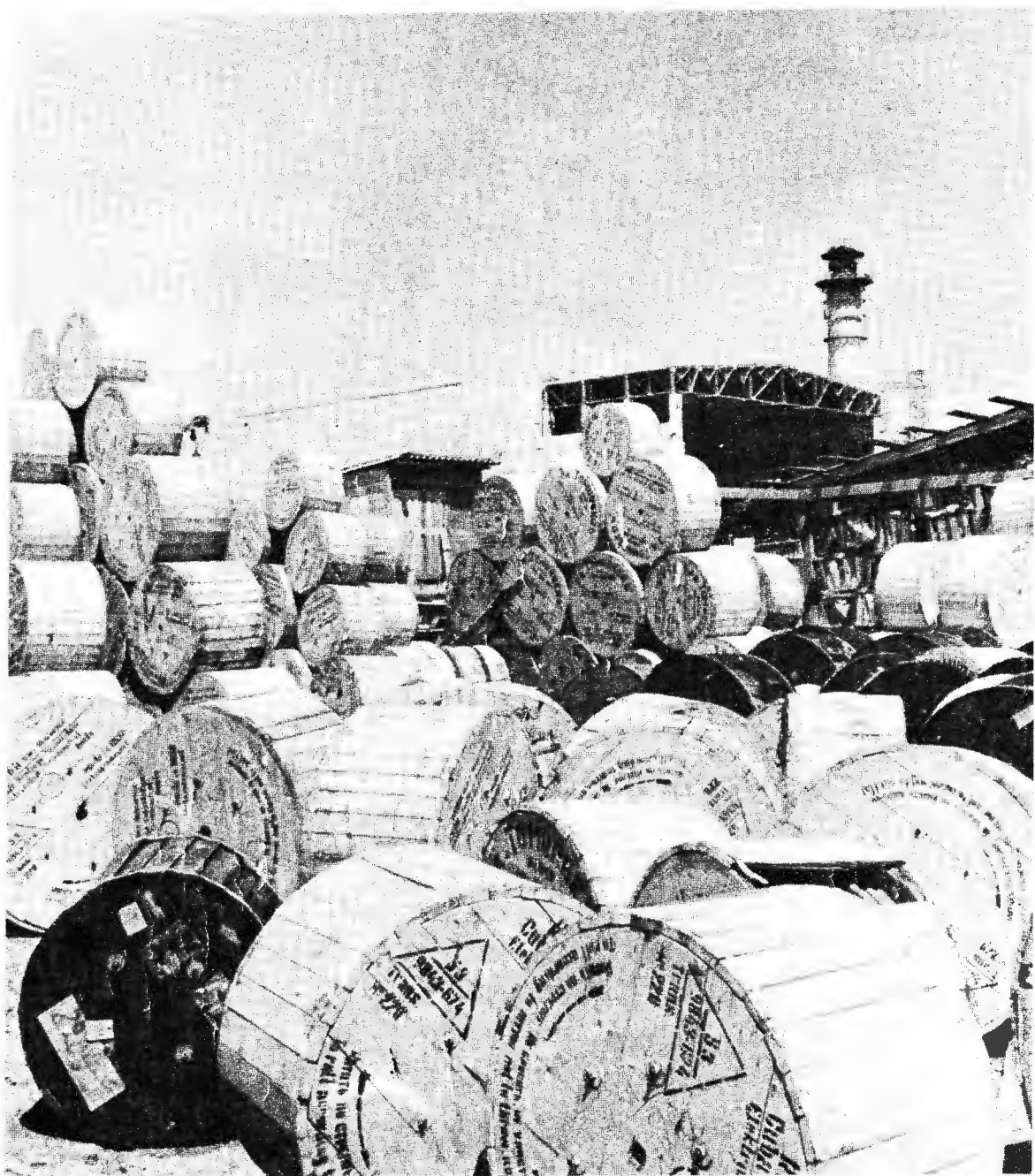
RENTE CONSUME KILOMETROS DE CABLES DE CONDUCCION ELECTRICA
