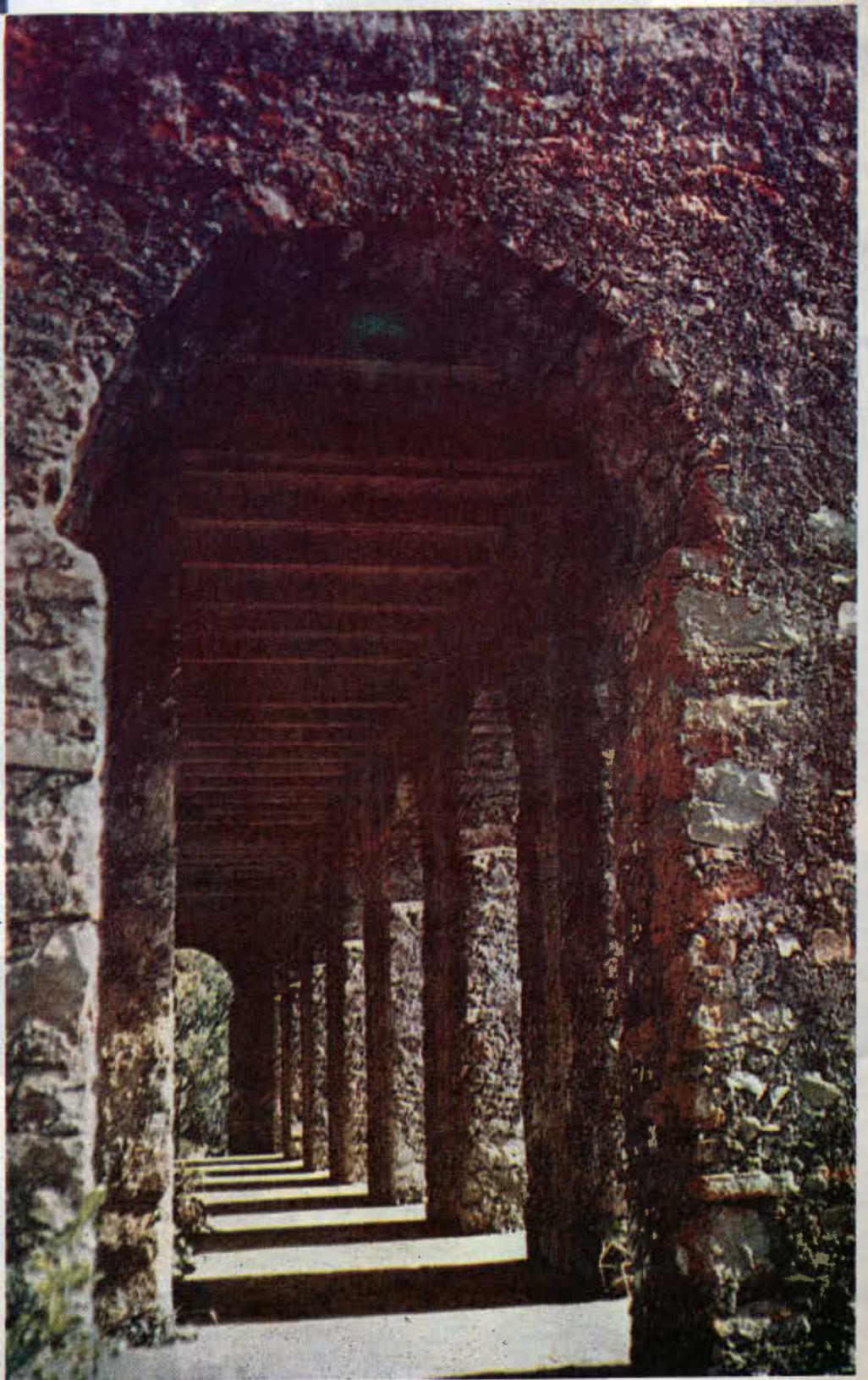
Treinta y ocho casonas de piedra, que eran verdaderos palacios de la época, han sido reconstruídos en "La Gran Piedra"
