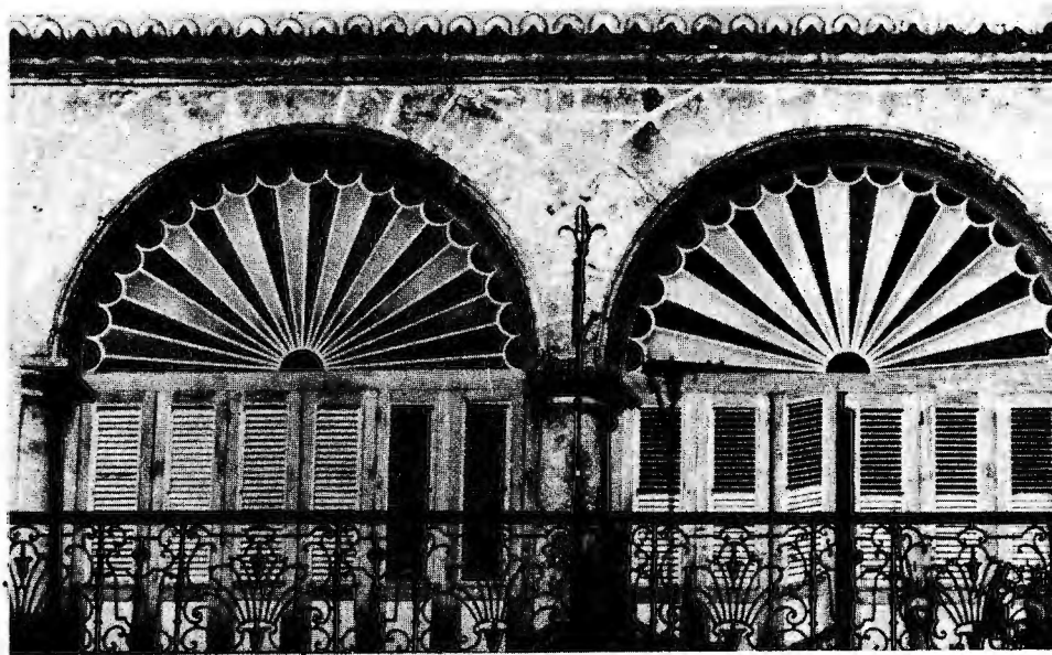
A la izquierda, vista de La Habana desde la fortaleza del Morro. Insertada, arriba, un rincón de la fortaleza. A la derecha, un contraste entre dos épocas: a la belleza barroca, del vidrio y de la filigrana, la belleza del cemento armado en busca del sol
