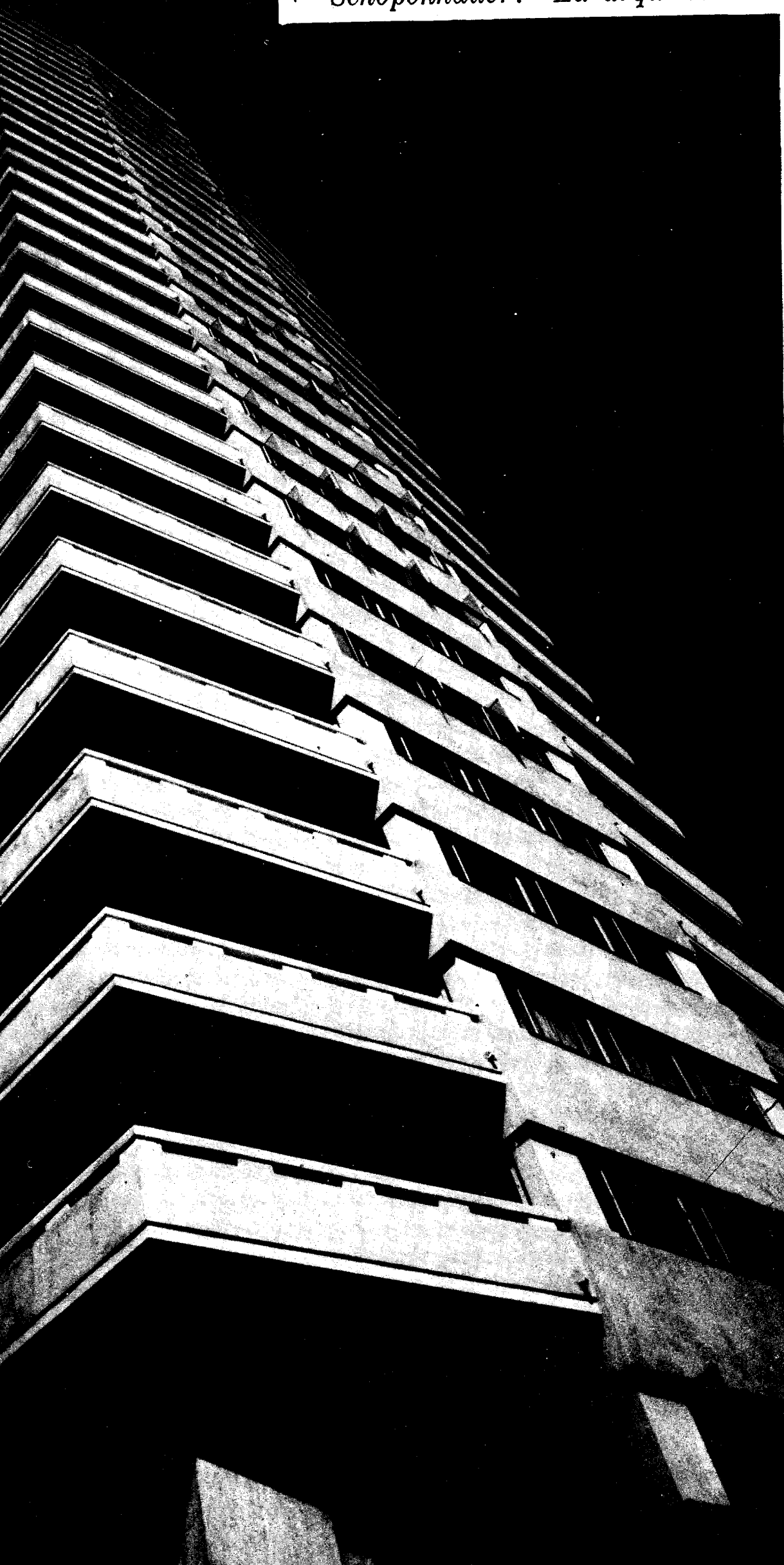
EDIFICIO DE APARTAMENTOS EN EL VEDADO. LA HABANA
