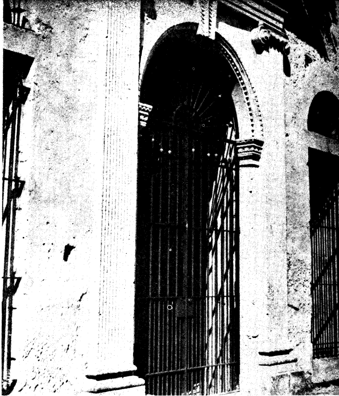
MARTÍ Y OTROS PATRIOTAS SUFRIERON TRAS ESTOS MUROS. AL DEMOLERSE LA ANTIGUA CARCEL DE LA HABANA, SE RESPETARON UN LOCUTORIO Y CUATRO CELDAS QUE SERVIRIAN DE PERDURABLE EJEMPLO EN LA DURA BATALLA POR UNA CUBA LIBRE.
