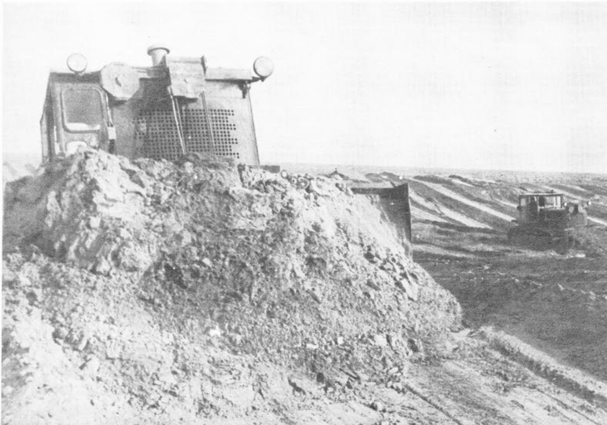
Equipos modernos se utilizan para la apertura del segundo tramo del canal entre los ríos Murgab y Tedzhen que lleva la vida al desierto.
