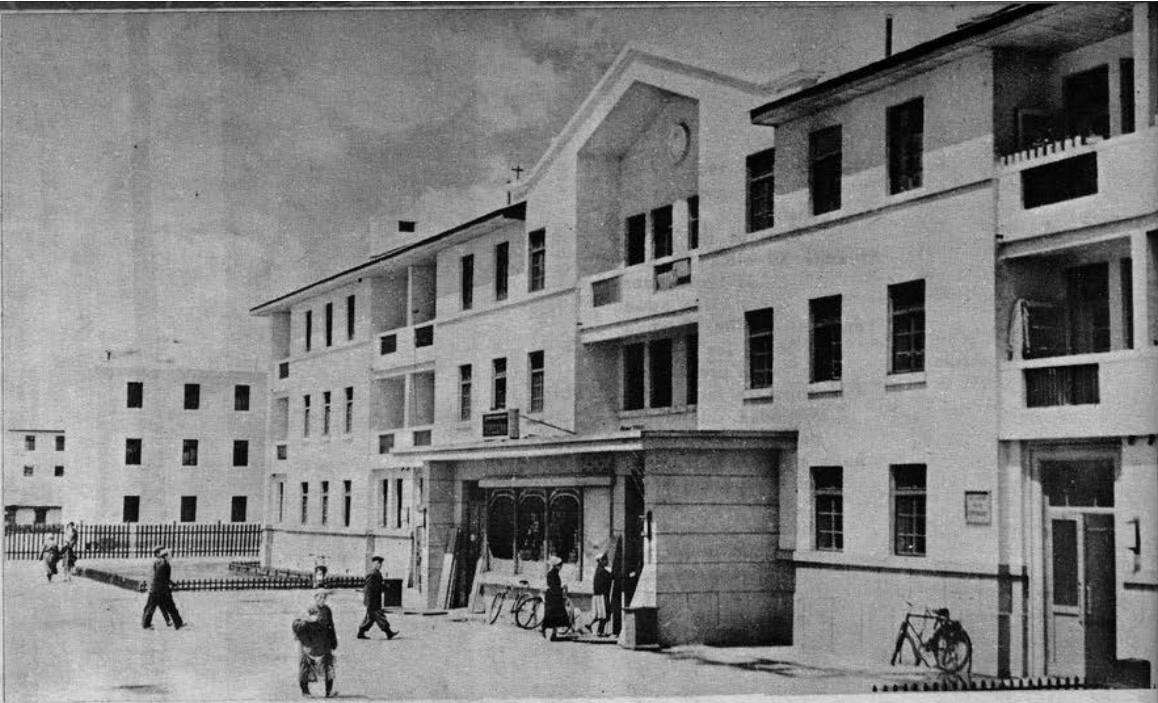
Casas de apartamentos hechas para los trabajadores de la fábrica de textiles de "Choibalsan", inmediata a Ulan-Bator, capital de Mongolia.
