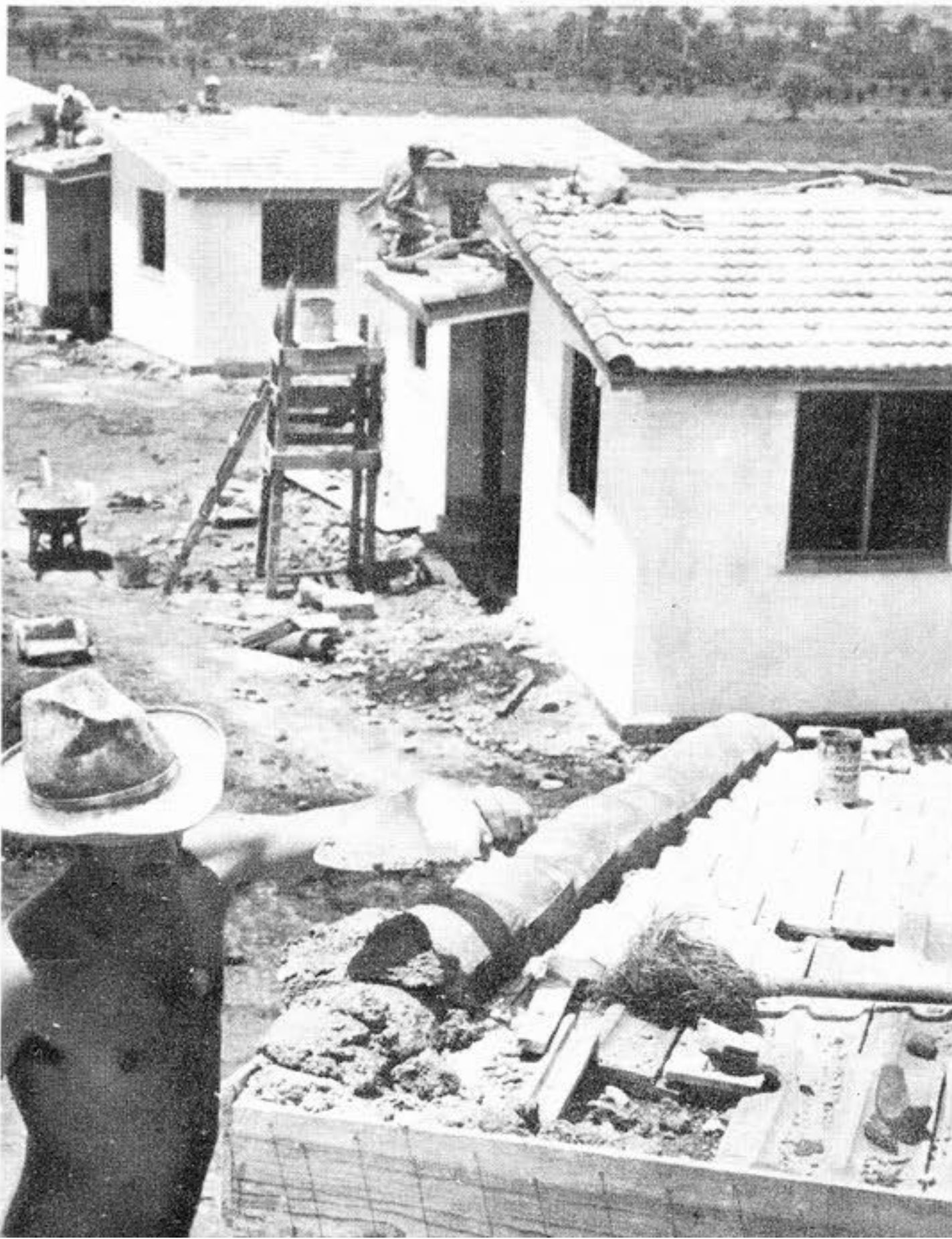
Todos los tipos de techos se han utilizado en las viviendas: prefabricados, de bloques y también de tejas, como vemos en la foto.
