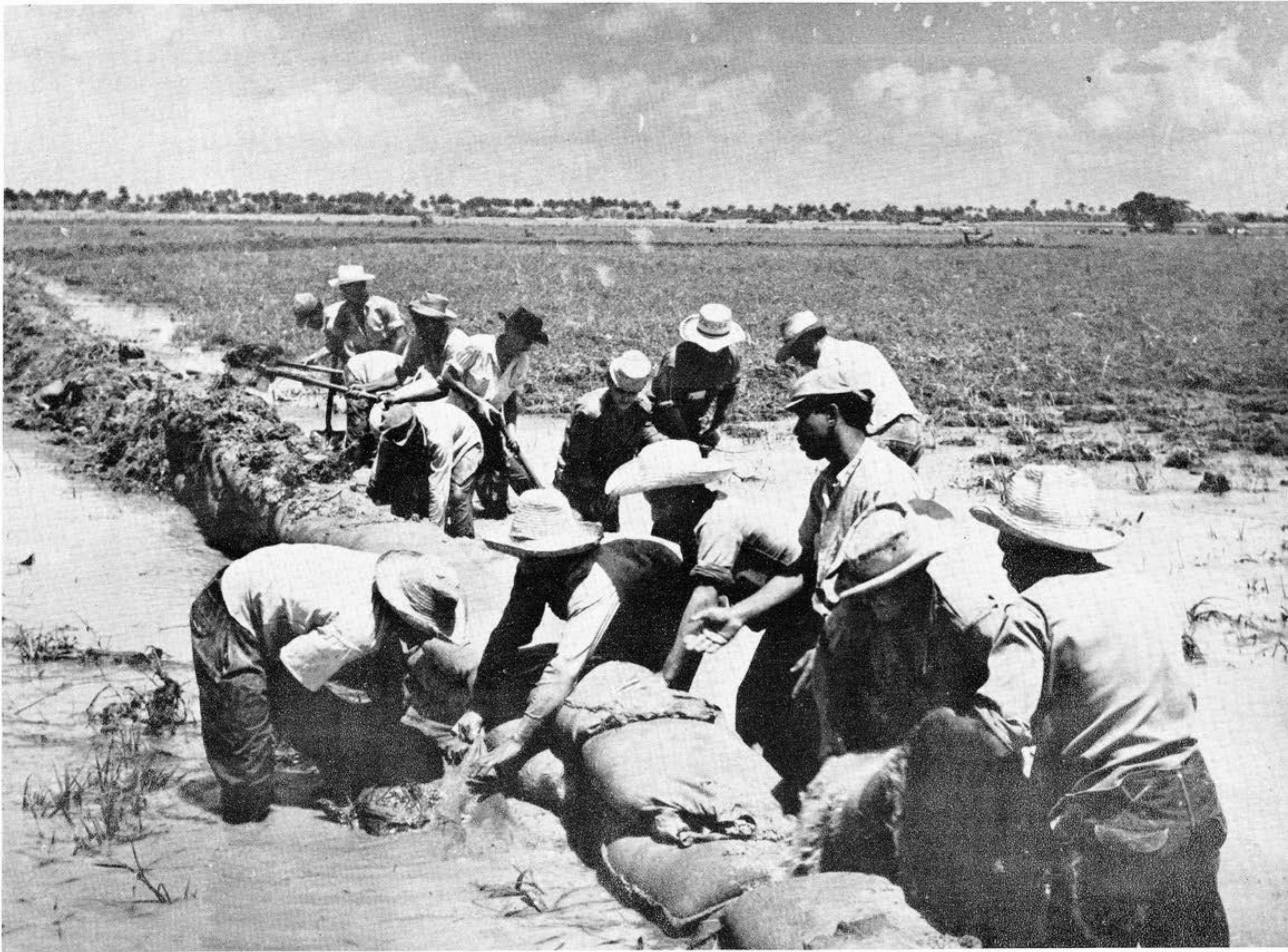
Se hacen diques para desviar el agua e inundar los campos de arroz.
