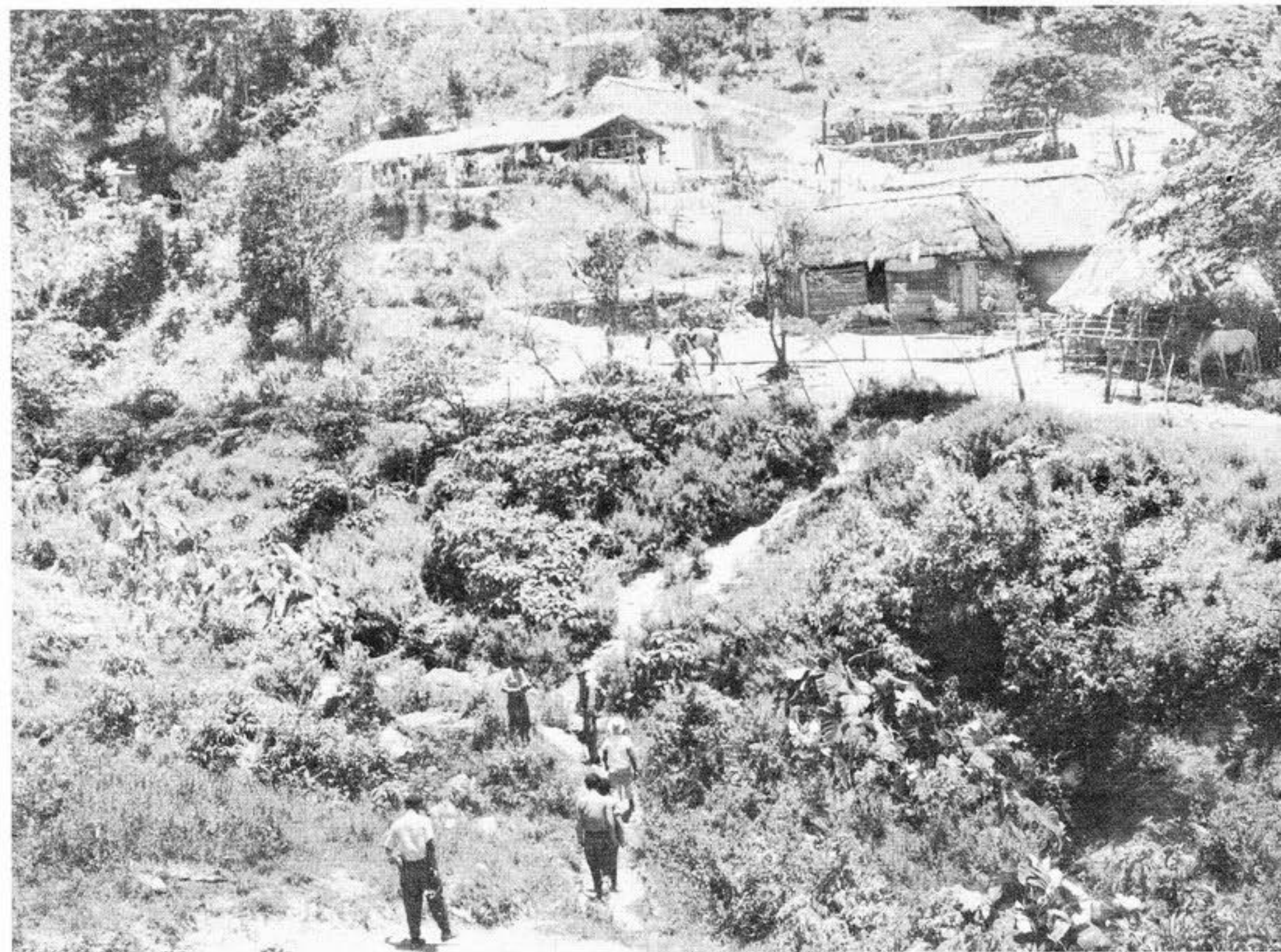
En los campamentos de las Minas del Frío el trasiego es constante. Un mundo nuevo está surgiendo en la Sierra Maestra.
