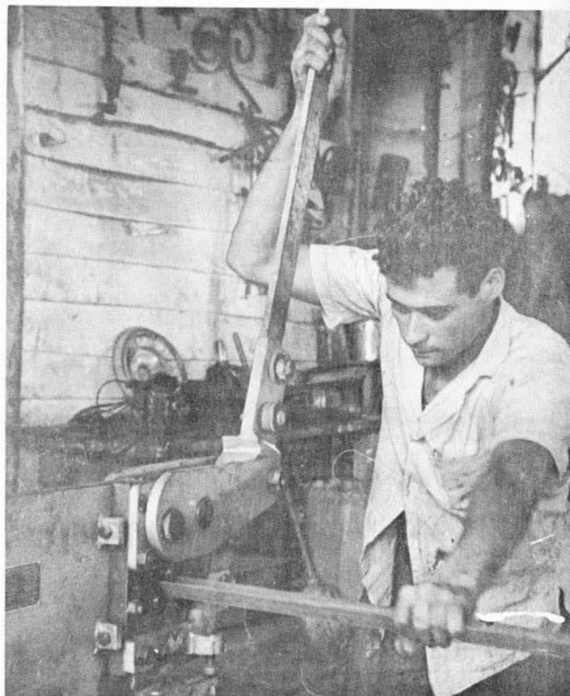
ESTA CUCHILLA O GUILLOTINA DE LA INVENCION DE TRIANA CORTA LOS ANGULARES DE LAS CAMAS COMO SI FUERAN DE PAPEL.
