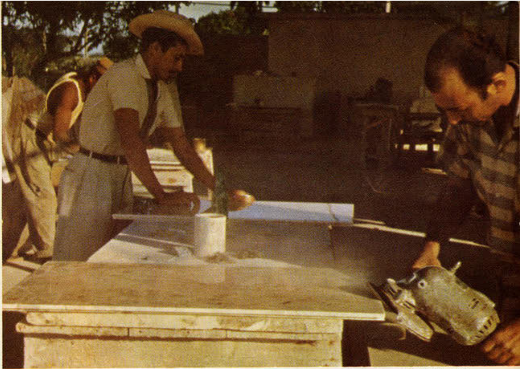
LA TERMINACION DE CADA PIEZA YA CORTADA SE REALIZA TAMBIEN MECANICAMENTE
