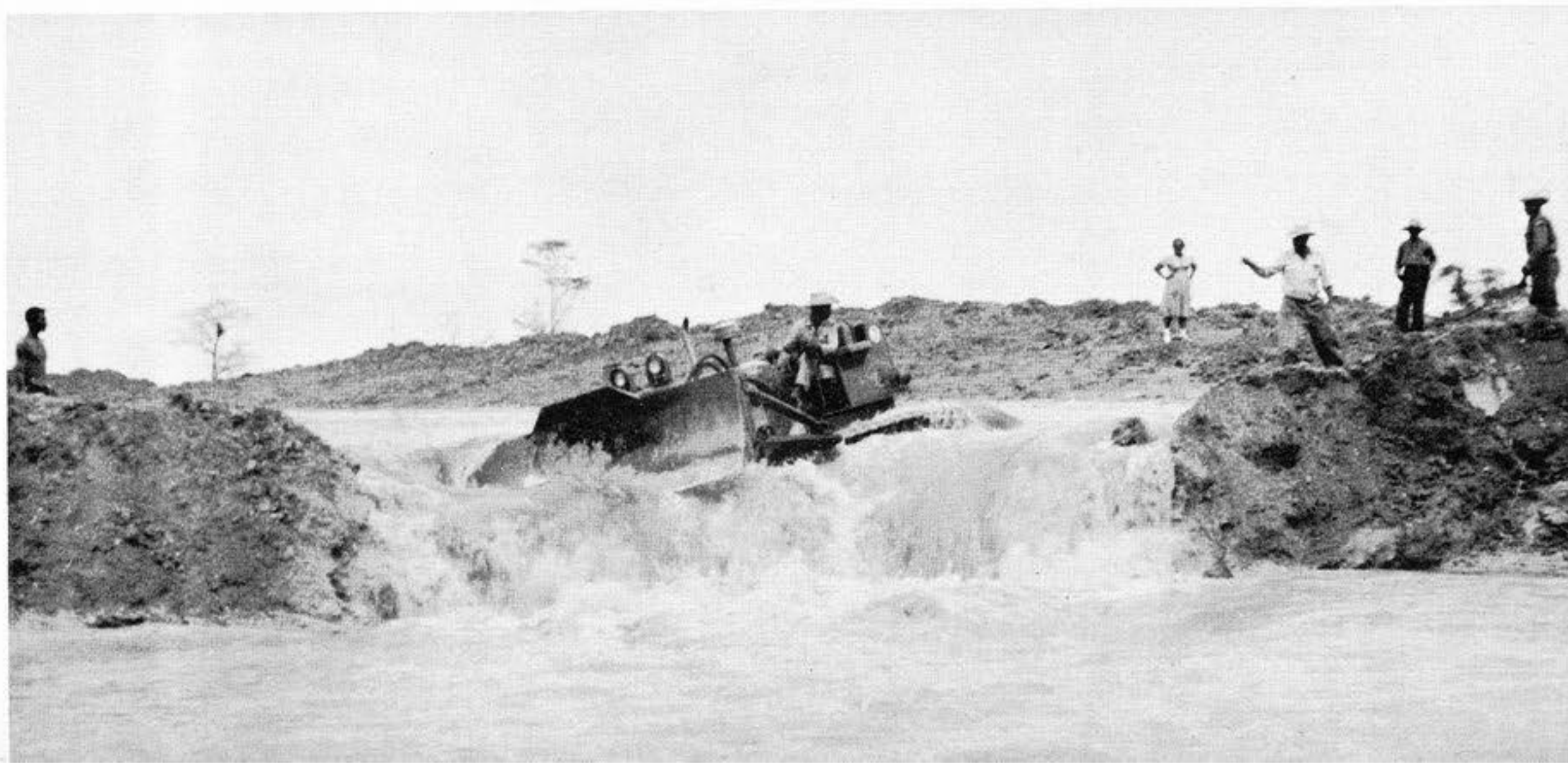
TRACTORES EN LA LABOR DEL CANAL CONDUCTOR DE LAS AGUAS DE LOS RIOS SALADO Y CAUTO AL TERRENO
