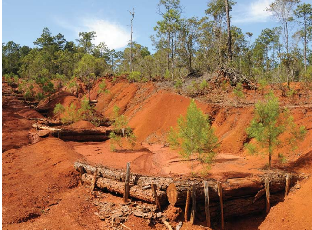
La deforestación y caminos mal diseñados en las montañas conducen a la erosión acelerada. Cárcava con medidas de corrección anti-erosiva en Nipe-Sagua-Baracoa.
