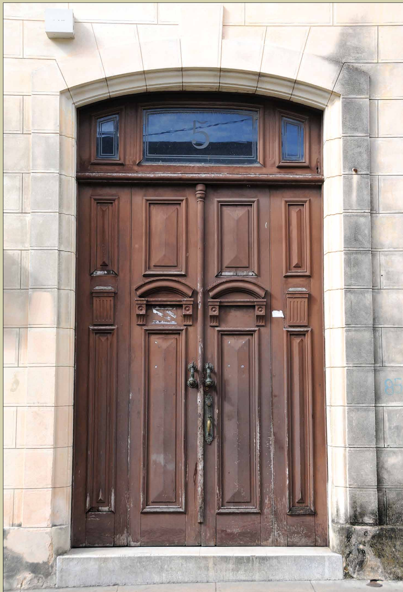
ILUST. 465 PUERTAS DE ENTRADA.
