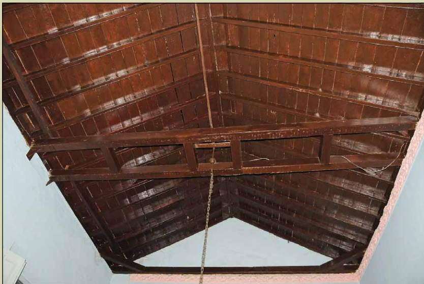
ILUST. 356 TECHOS DE ARMADURA DE LA PRIMERA CRUJÍA.
