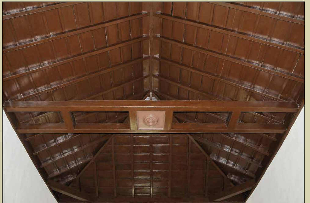
ILUST. 356 TECHOS DE ARMADURA DE LA PRIMERA CRUJÍA.
