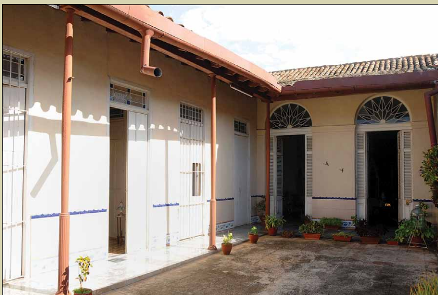
ILUST. 306 PATIO DE LA CASA DE MILANÉS 16½.
