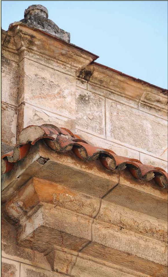
ILUST. 387 DETALLES DE LA CORNISA Y EL PRETEL, Y REJA DE RÍO 21.
