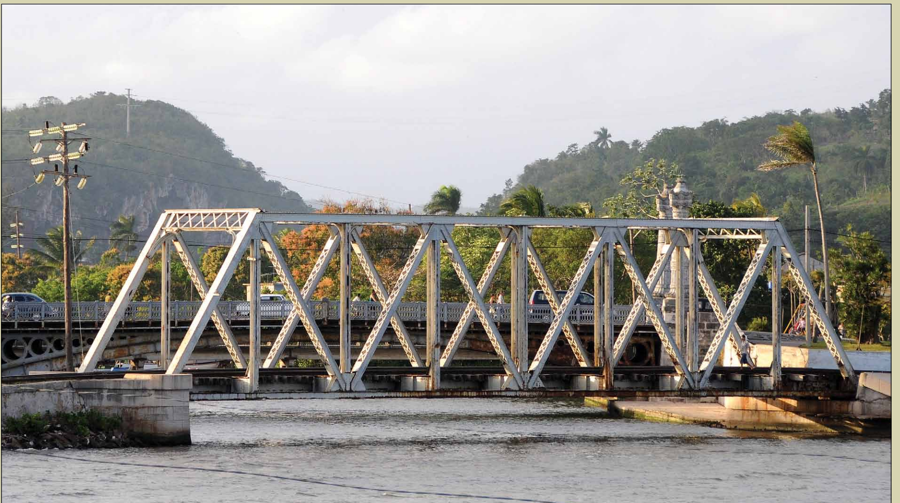
ILUST. 253 PUENTE DE HIERRO DEL FERROCARRIL SOBRE EL RÍO YUMURI, 1904.
