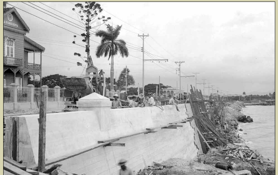
ILUST. 282 CONSTRUCCIÓN DEL MALECÓN EN LA CALZADA PEDRO BETANCOURT, CORTESÍA JUAN DE LAS CUEVAS.
