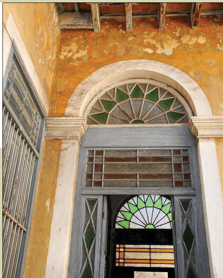
ILUST. 461 ARCOS CON MEDIOPUNTOS Y LUCETAS RECTANGULARES, MILANÉS 66.
