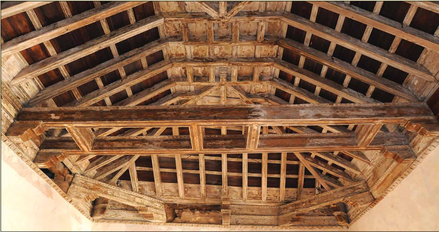
ILUST. 320 TECHO DE ARMADURA DEL CUARTO ESQUINERO.
