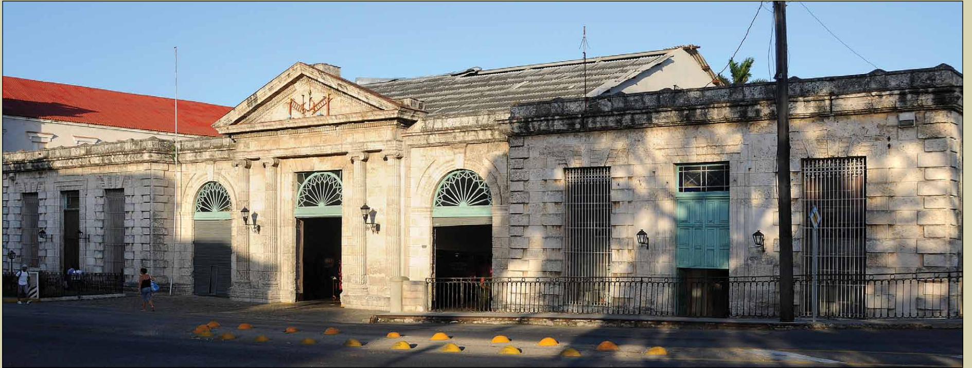
ILUST. 225 CUARTEL DE BOMBEROS DE MATANZAS, PLAZA DE LA VIGÍA.
