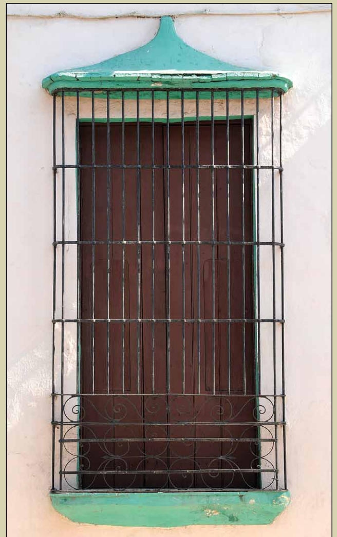
ILUST. 310 GUARDAPOLVOS CONOPIALES DE REMATE DE LAS REJAS DE VENTANAS.
