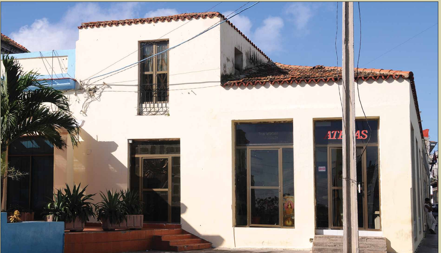
ILUST. 313 TIENDA ESQUINERA DE MAGDALENA ESQUINA MILANÉS.
