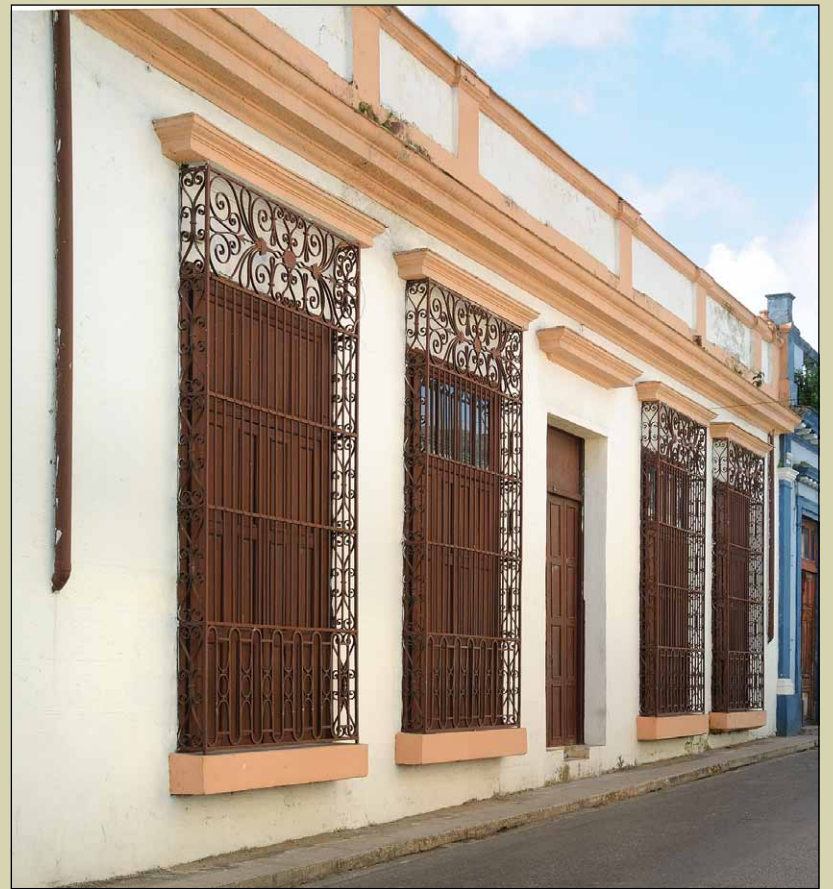
ILUST. 388 FACHADA DE RÍO 23.
