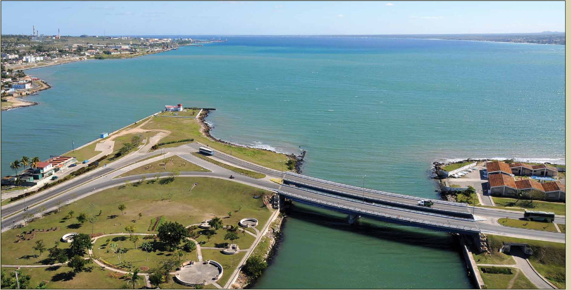
ILUST. 62 ZONA DEL MUELLE, EN LA ACTUALIDAD.
