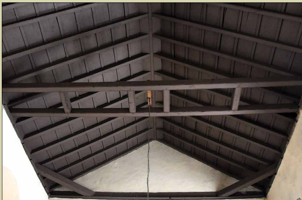
ILUST. 311 TECHOS DE ARMADURA DE MADERA SOBRE LA PRIMERA CRUJÍA.
