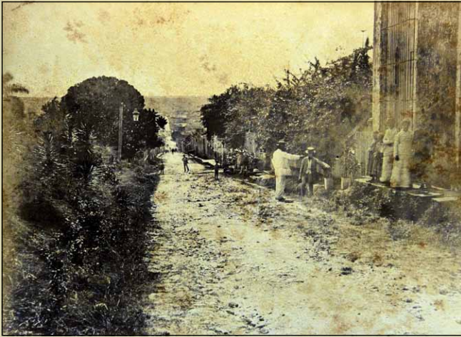
ILUST. 279 CALLE 2 DE MAYO EN 1880, SIN PAVIMENTAR.
