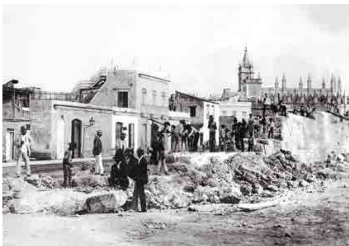
Demolición de la muralla en la actual avenida de las Misiones, 1889
