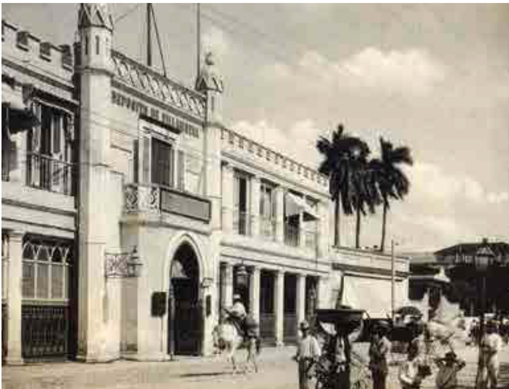
Entrada principal de la estación de Villanueva por la calle Dragones
