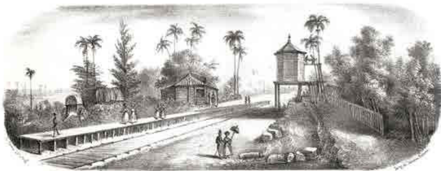
Camino de hierro en la Aguada del Cura
