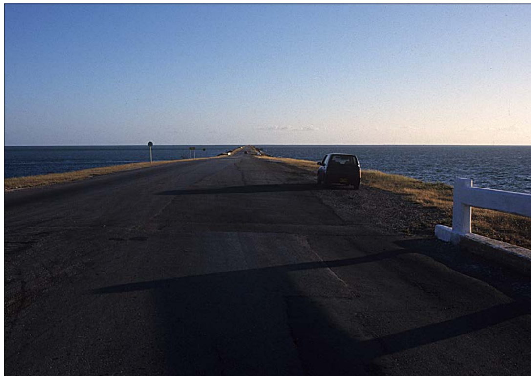
FIG. 616. Viaducto de Cayo Coco
