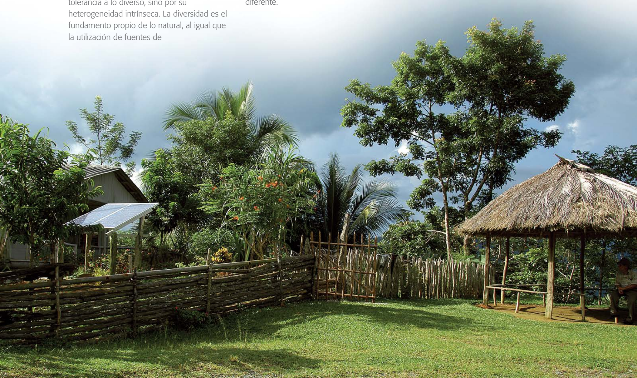
FIG. 33. El aprovechamiento de la energía solar, además de no dañar el medio ambiente, resulta compatible con la biodiversidad que existe en el entorno de las instalaciones.
