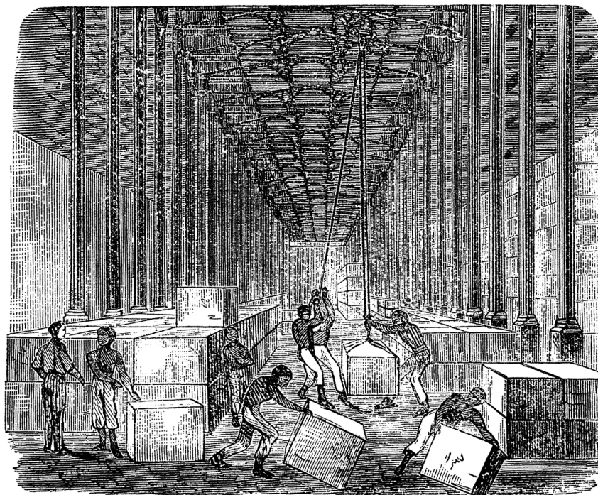
FIG. 16. INTERIOR DE UN ALMACÉN DE REGLA
