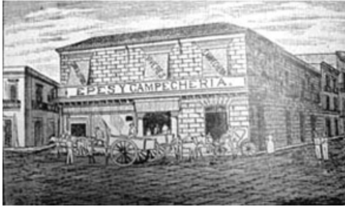
Ilustración 2 Casa de Armona, comercio ubicado en la calle Lamparilla, no. 42.
